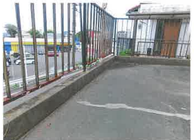
鉄柵の腐食状況
