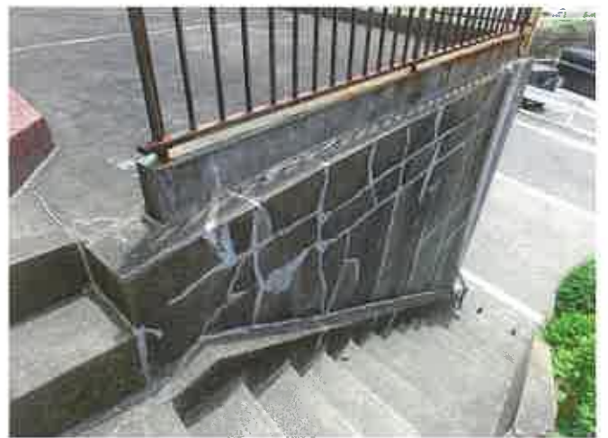
鉄柵の腐食状況
