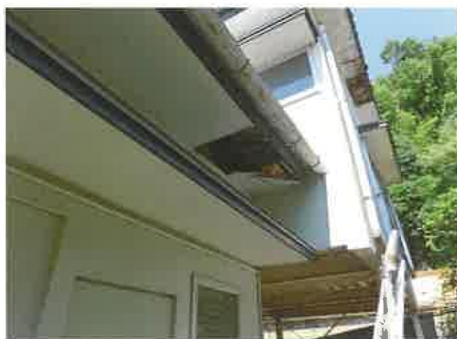
軒裏の損傷状況
