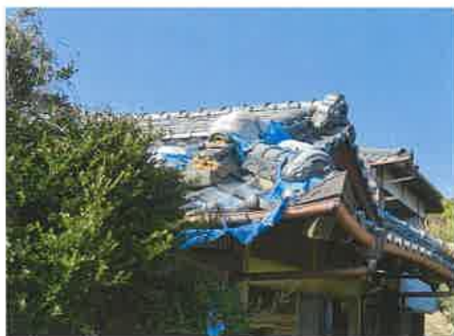
屋根瓦の損傷状況
