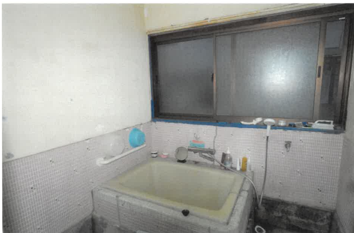
(写真⑭) 本件建物(物件4)の内部
