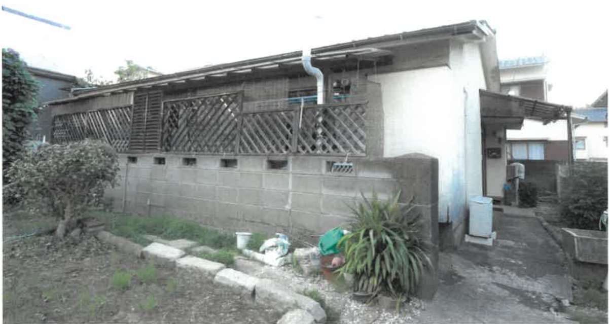
(写真④) 本件土地・建物(物件4)の外景
