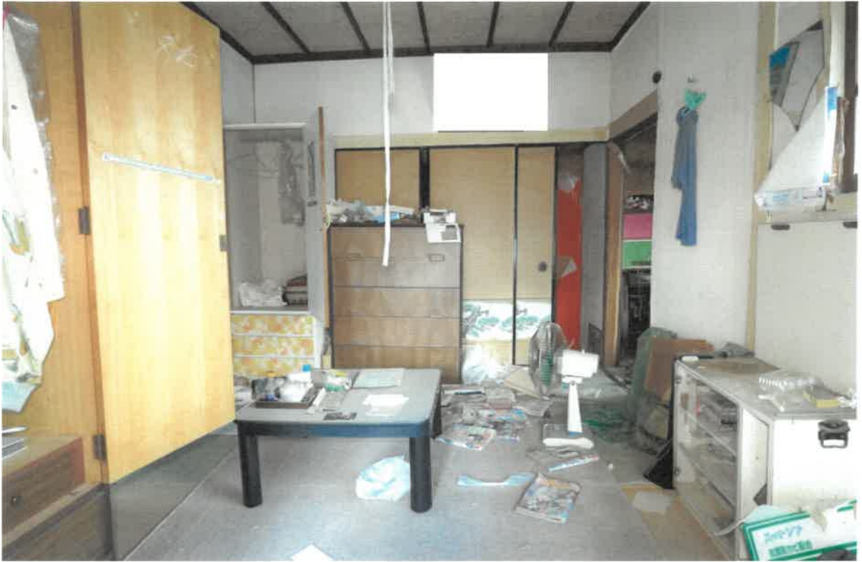
(写真⑦) 本件建物(物件3)の内部
