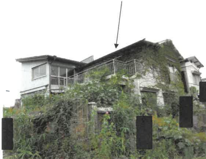
写真②本件建物越境部分
