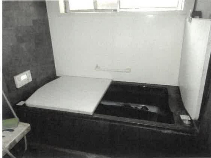
写真⑧建物内部
