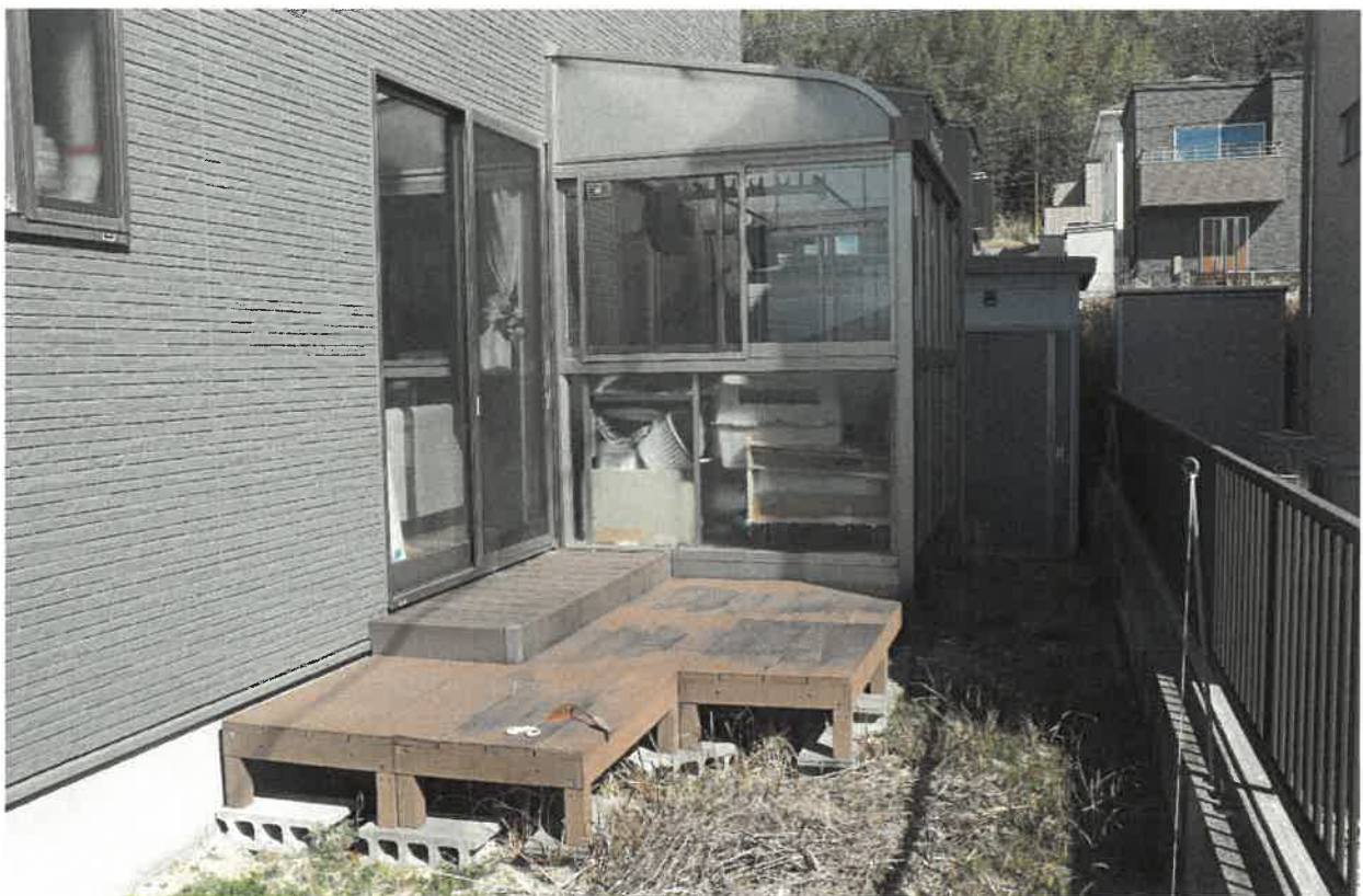
未登記増築箇所（サンルーム）及びウッドデッキ
