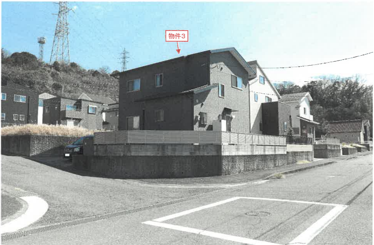
対象物件；北西より
