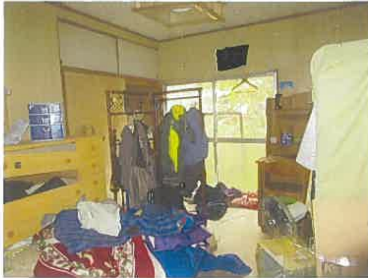
写真⑪建物内部
