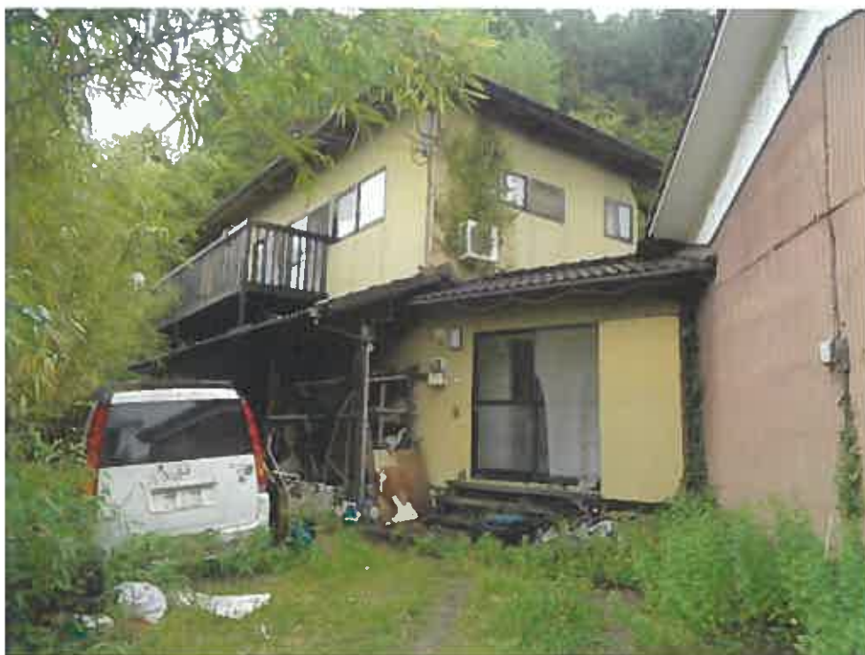
(写真2) 本件建物
