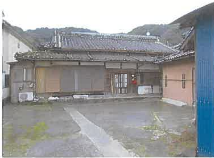
写真②附属建物
