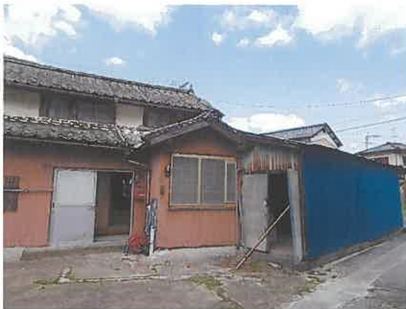
物件 2（附属建物） 未登記増築部分
