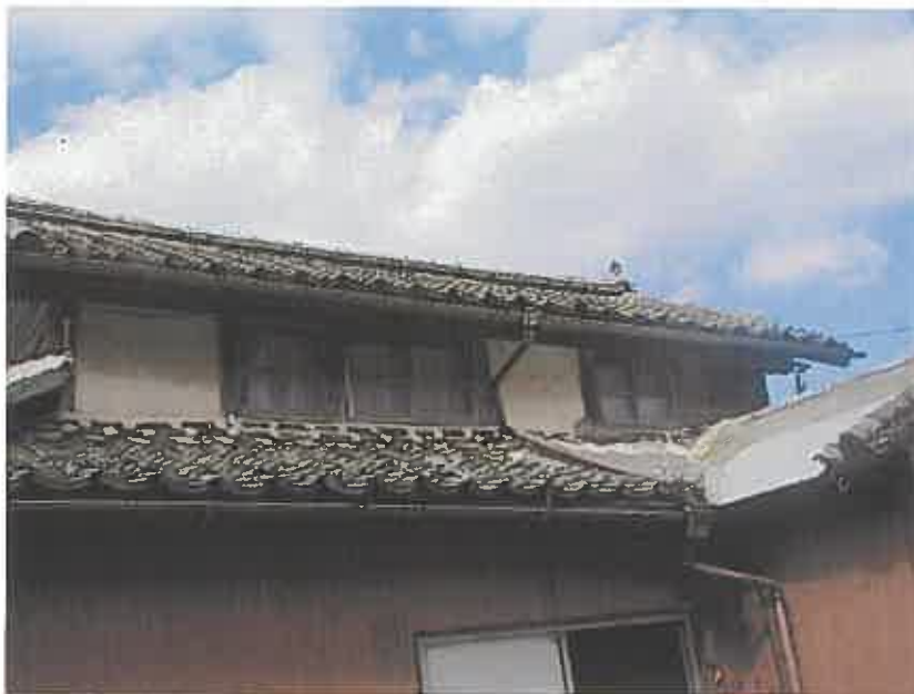
物件 2（附属建物） 屋根部分
