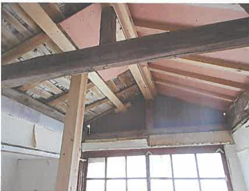
物件 2（附属建物） 天井部分
