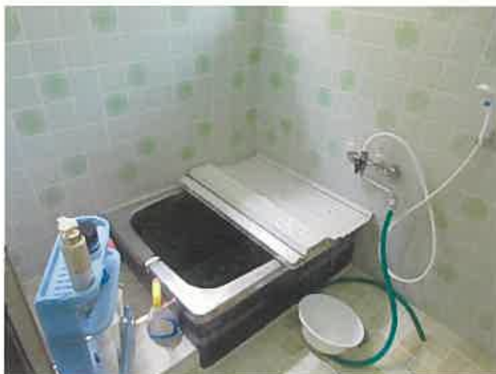
写真⑧建物内部
