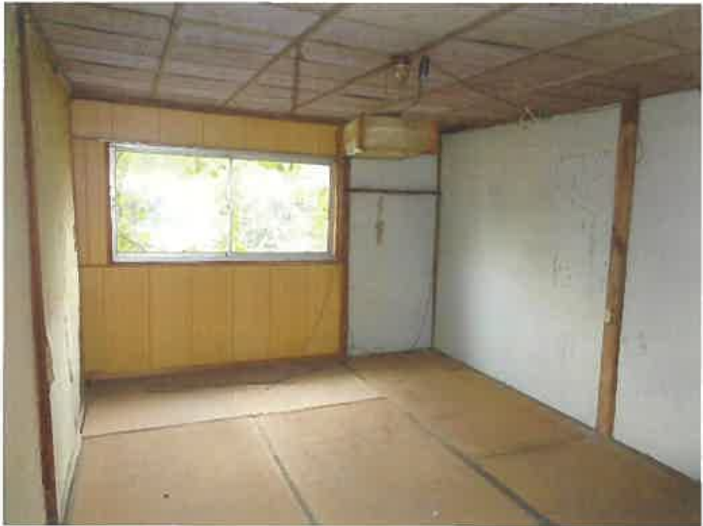
(写真9) 本件建物内部(2階)
