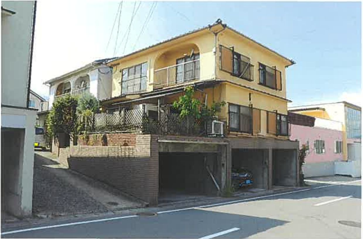
対象物件；南東より
