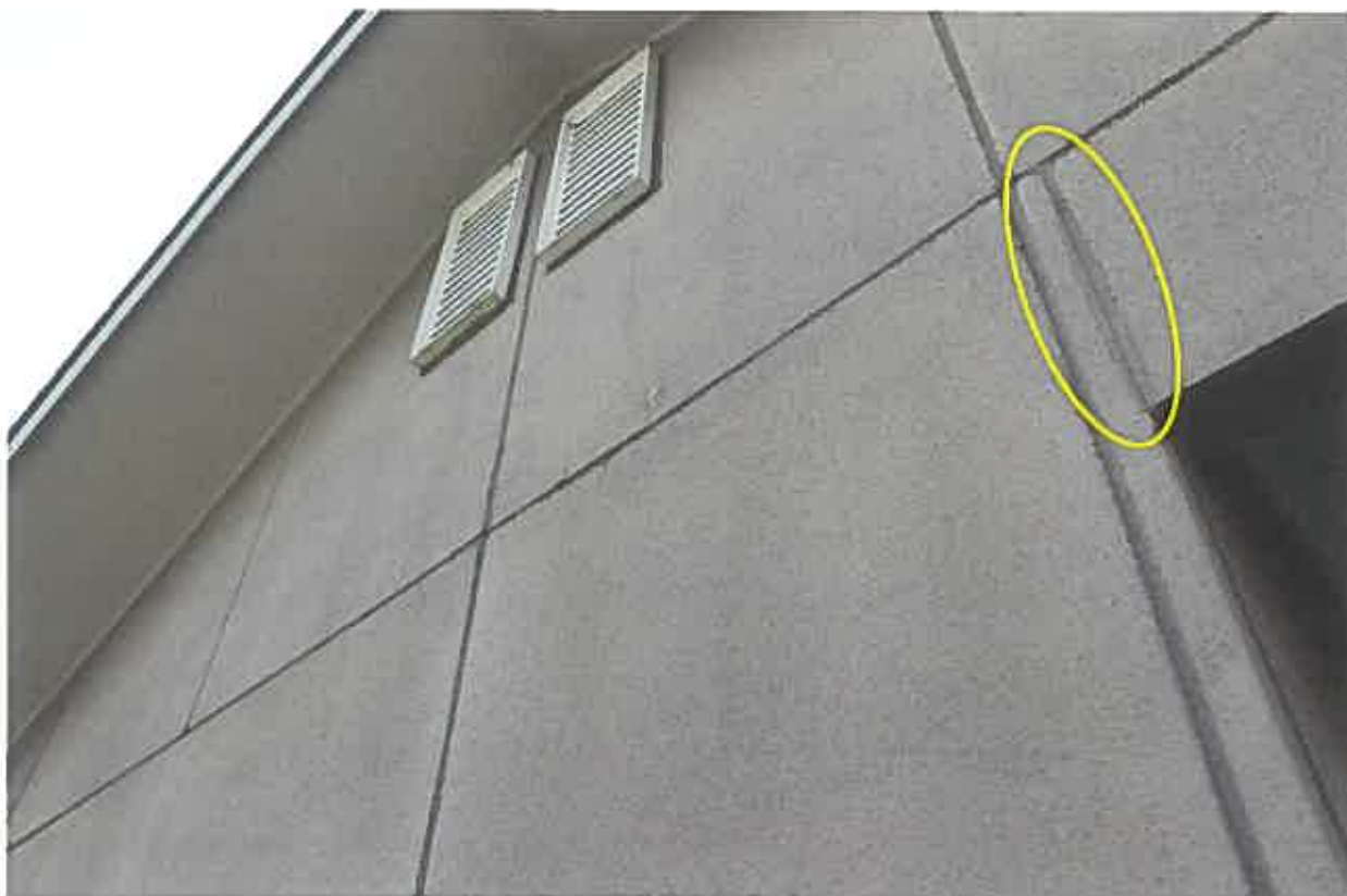
外壁の汚損・目地補修状況
