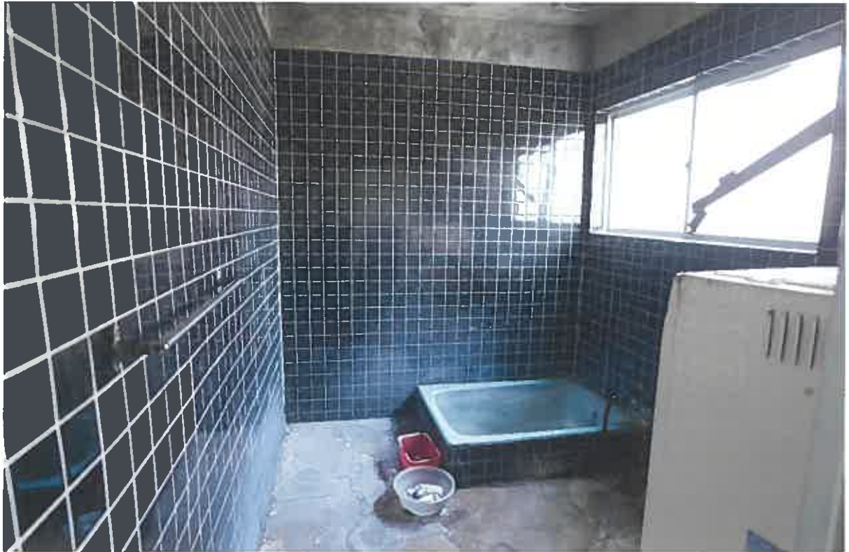
(写真⑨) 本件建物4の内部
