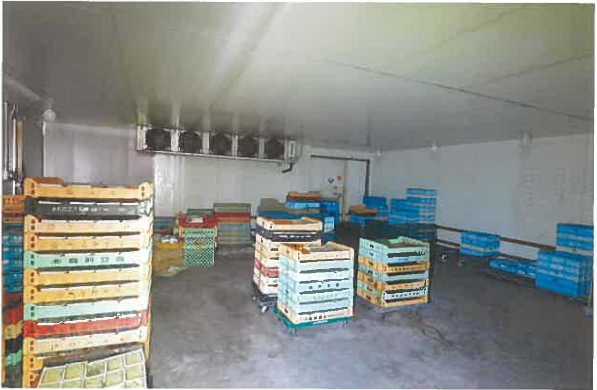
(写真③③) 本件建物7の内部
