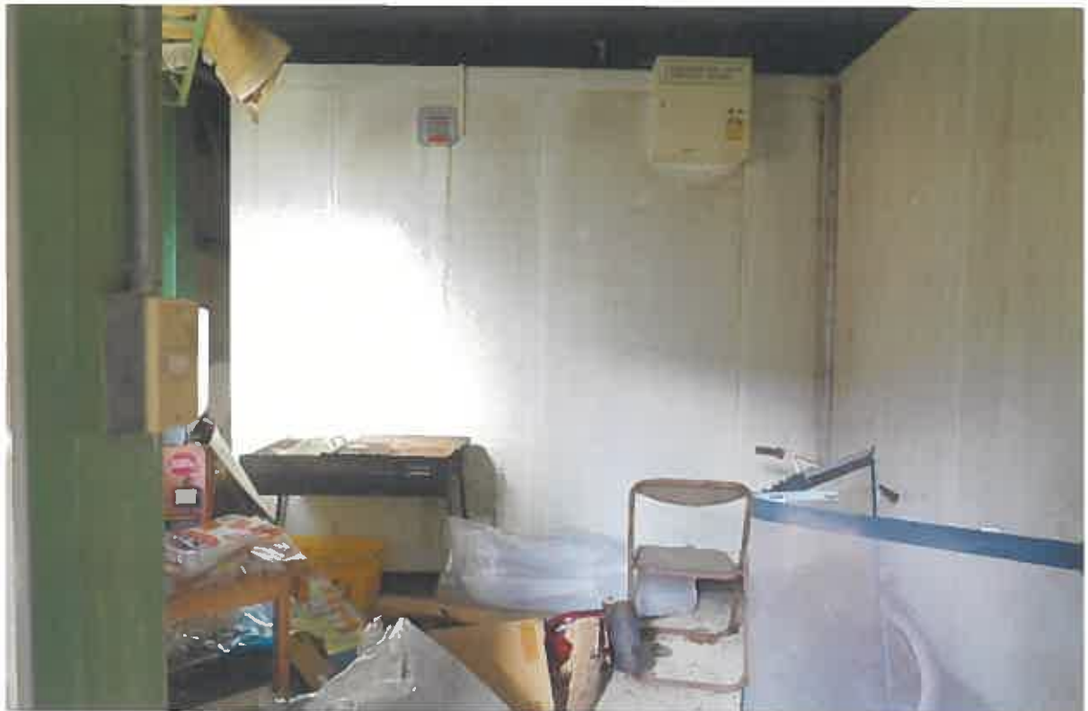
(写真③④) 本件建物7の内部
