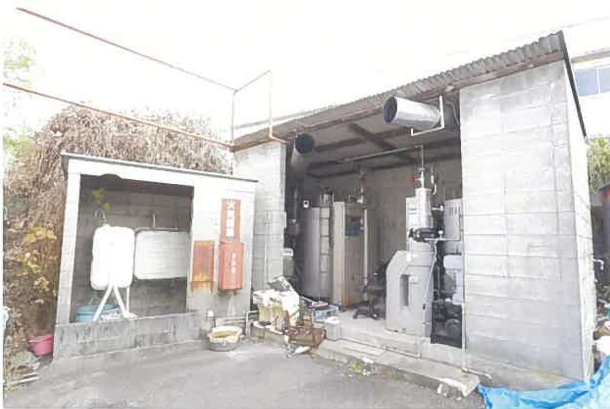
(写真56) 売却対象工作物重油置場及びボイラー置場
