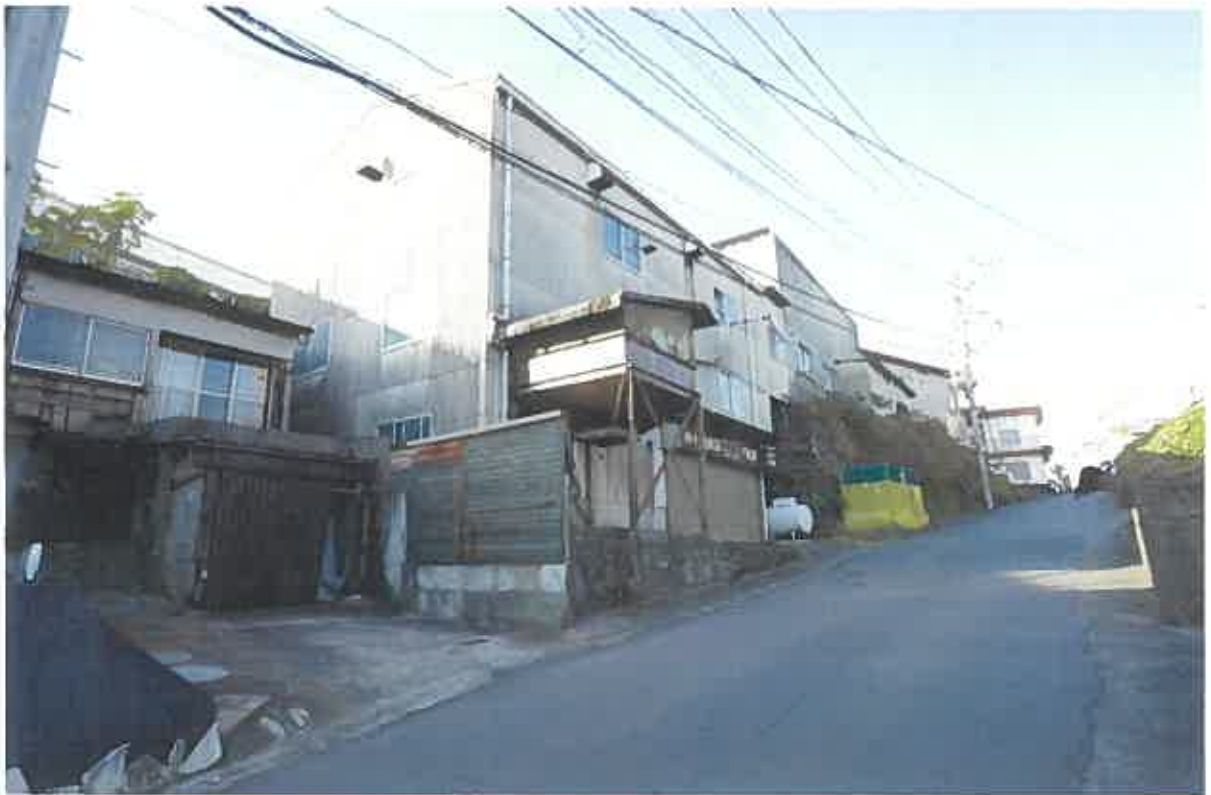
(写真48) 本件建物17の外観
