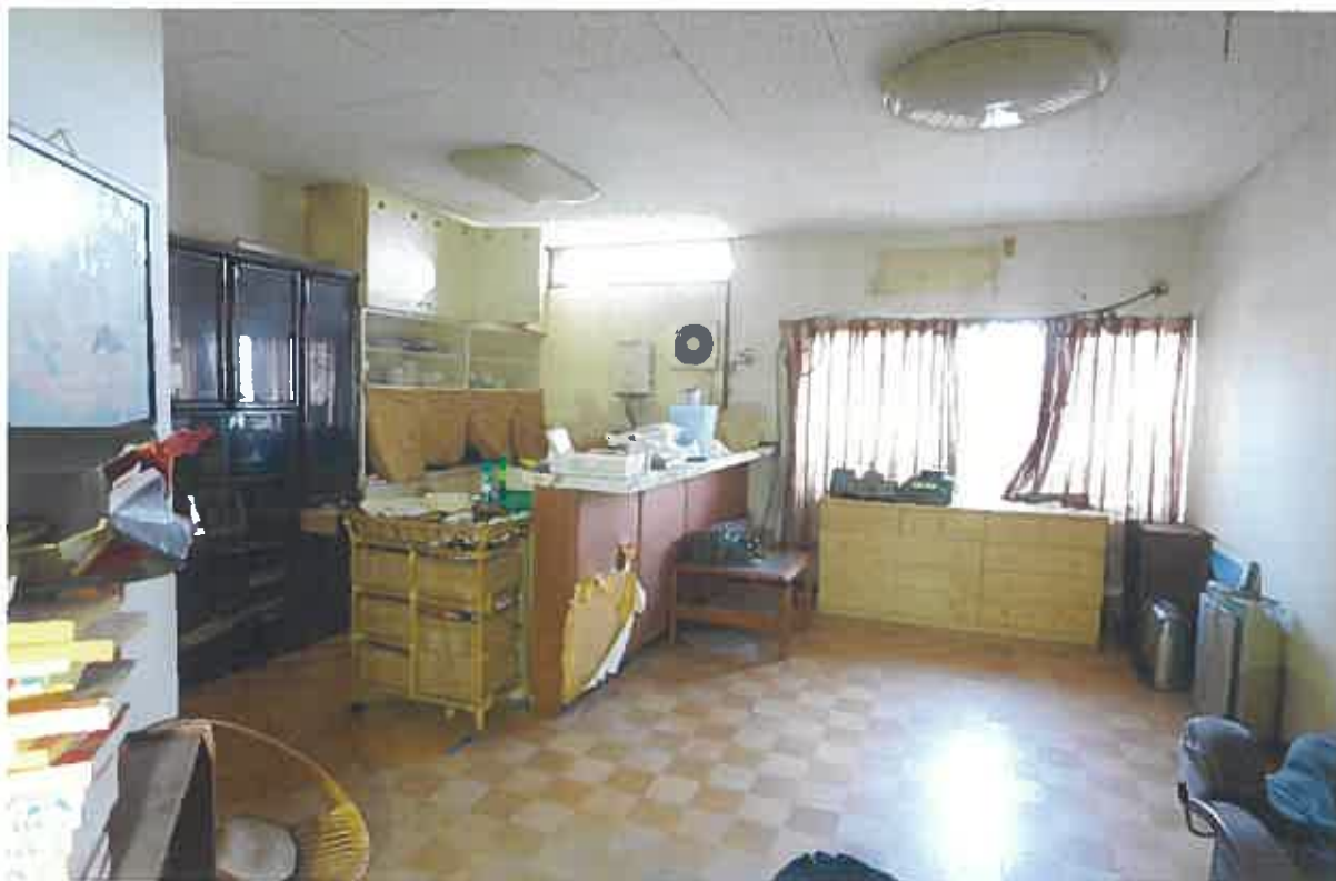
(写真③⑦) 本件建物7の内部
