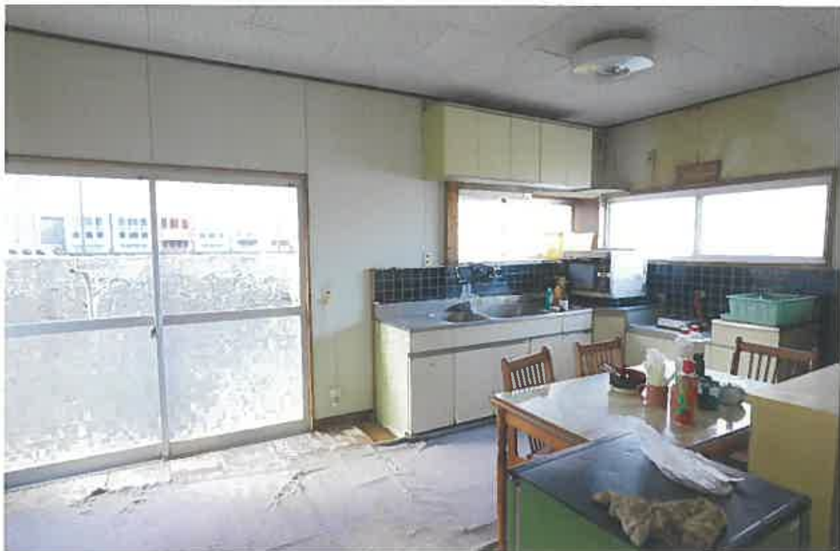
(写真⑦) 本件建物4の内部
