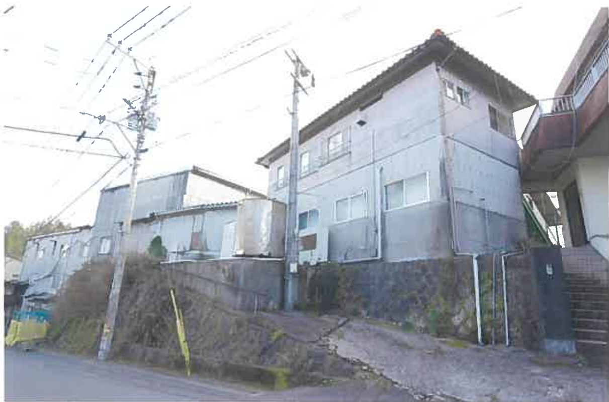
(写真30) 本件建物7の外観
