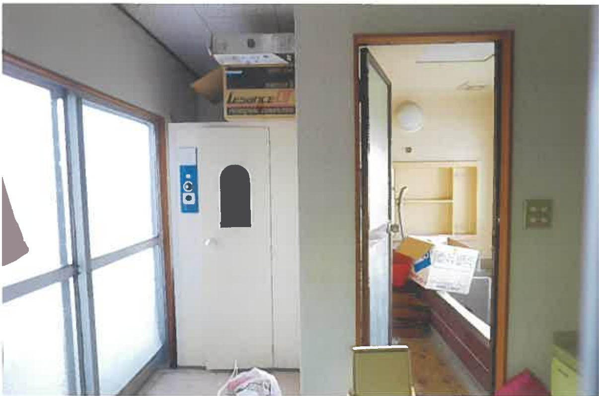
(写真㉕) 本件建物6の内部
