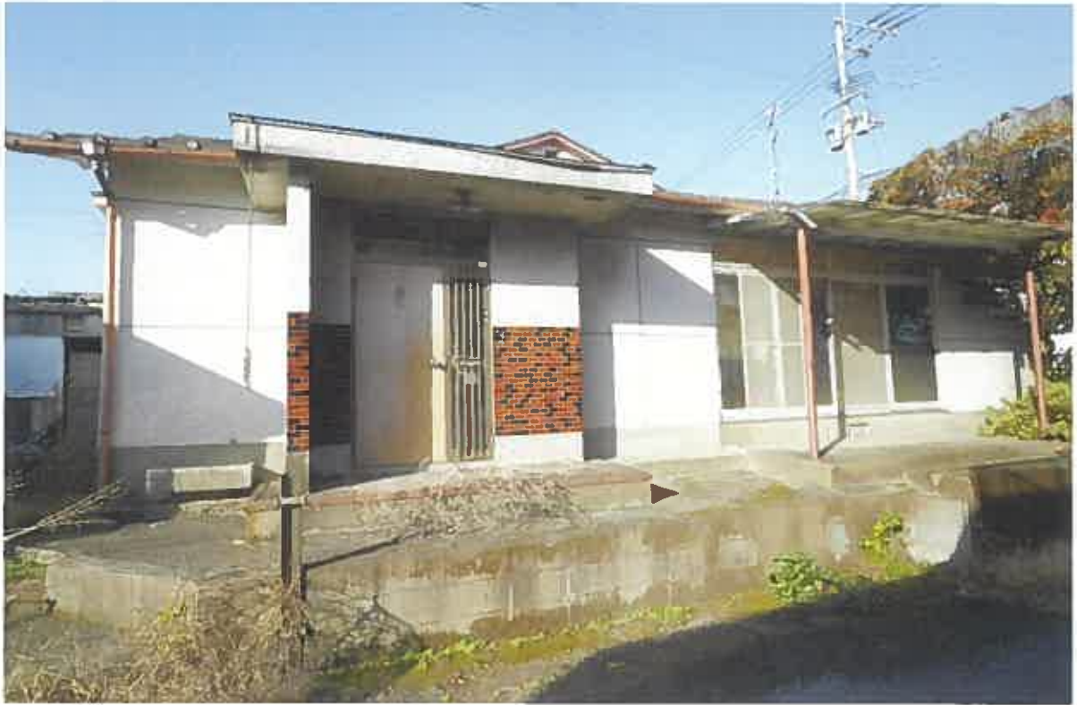
(写真①) 本件土地1・建物4の外景
