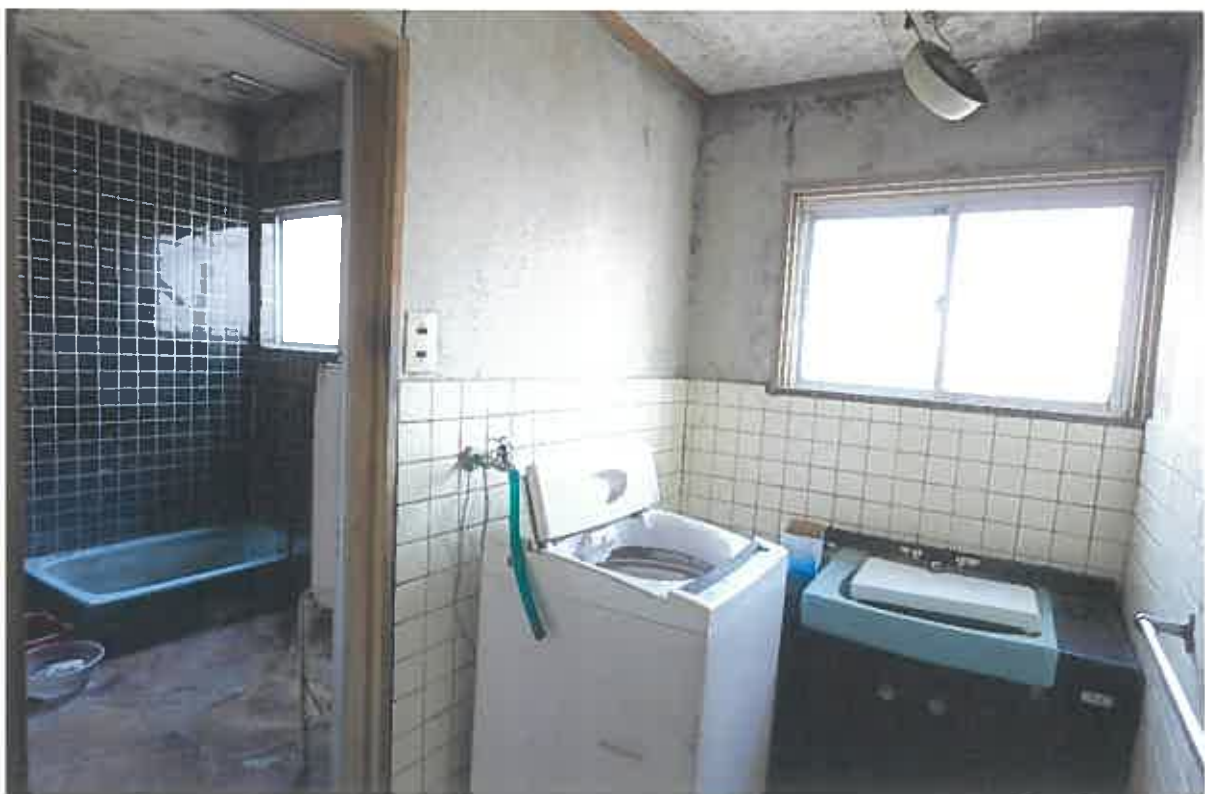
(写真⑧) 本件建物4の内部
