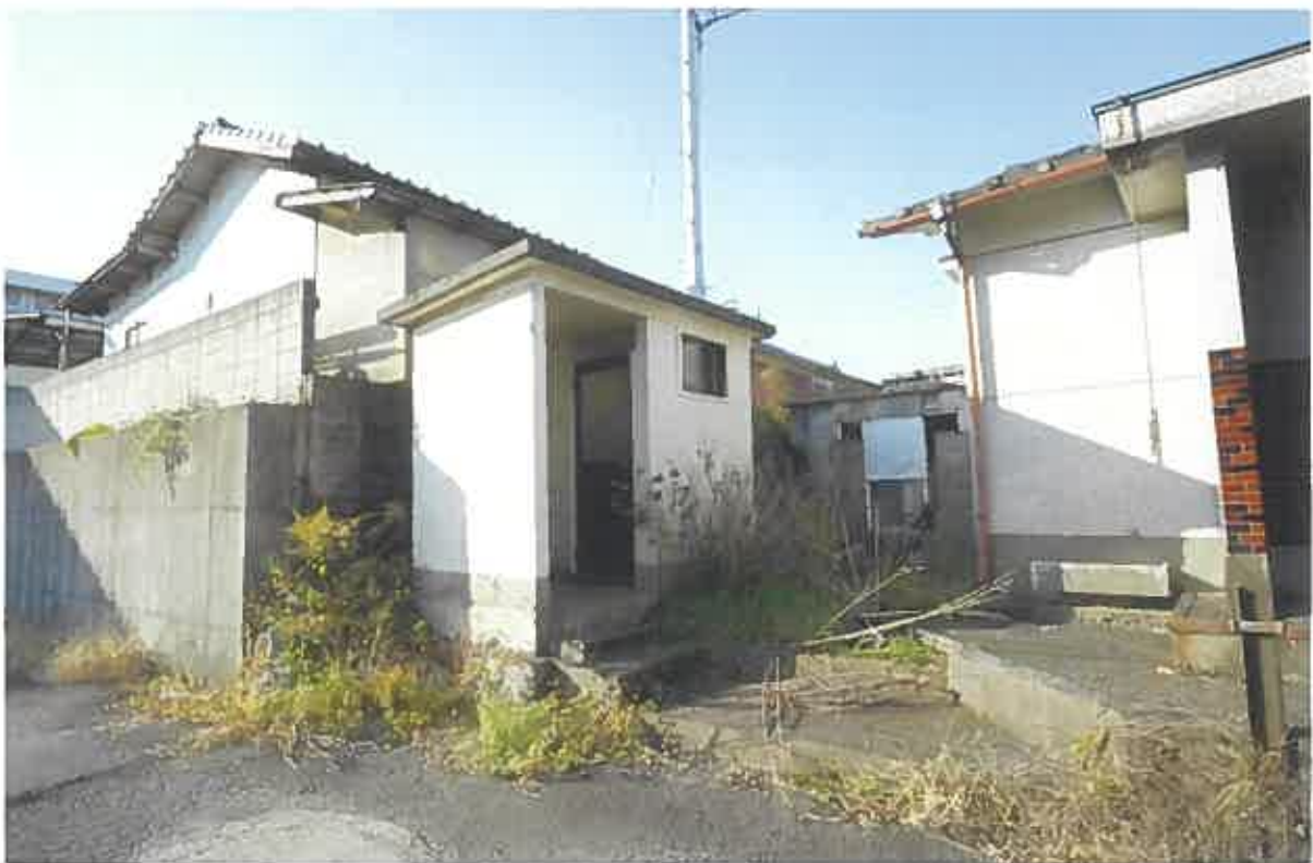
(写真②) 建物4未登記附属建物・附属建物の外景
