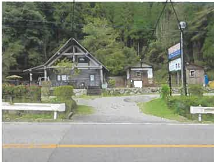
写真②BBQスペース（屋根付）
