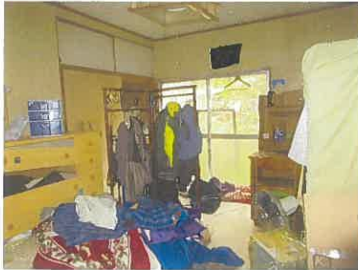
写真⑪建物内部
