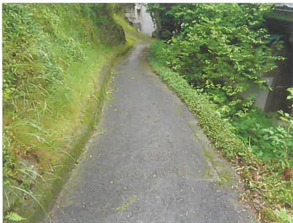
(写真7) 本件各土地の接面道路(里道)
