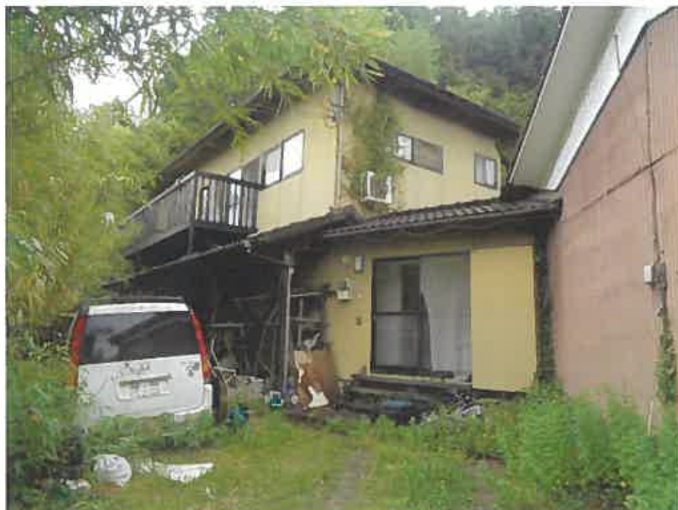
(写真2) 本件建物
