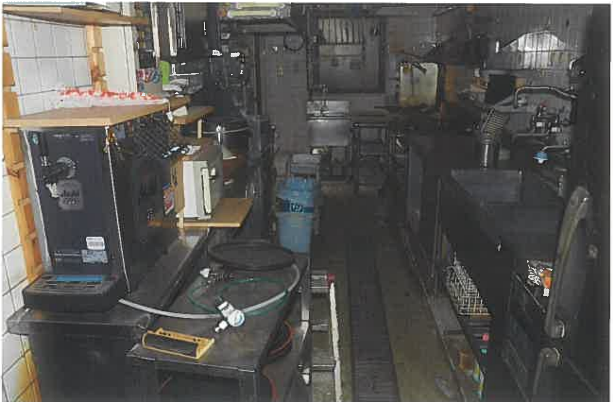
1階：東側厨房（煮・焼・揚物）
