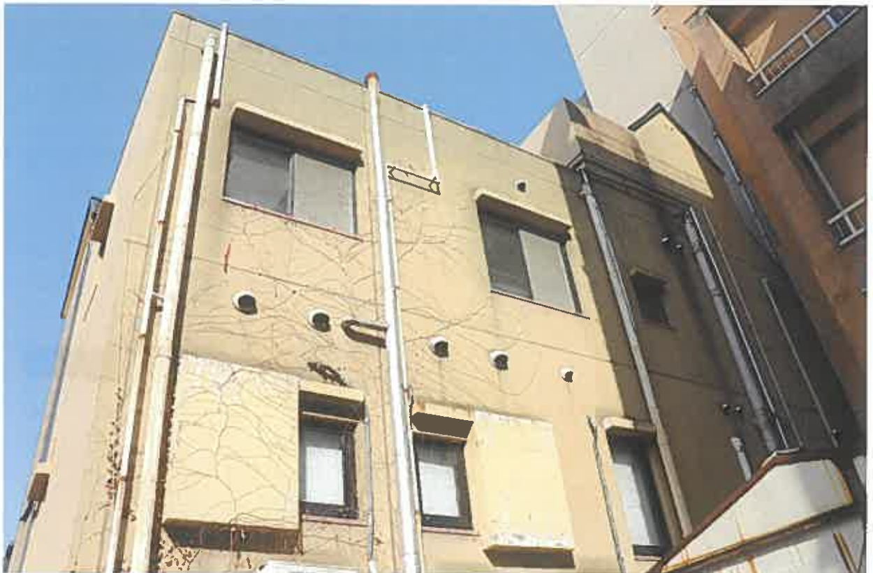
物件2；南側外壁の状態
