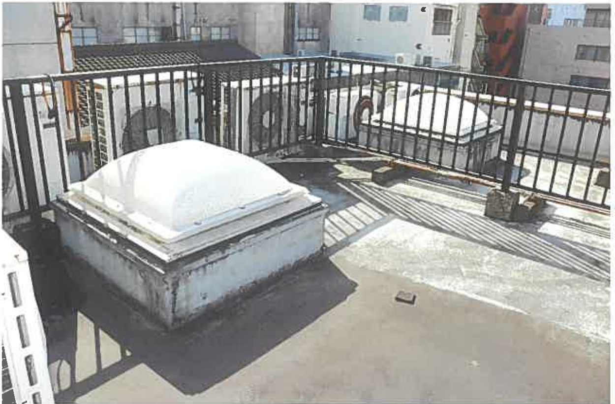
4階屋上；天窗用トップライト
