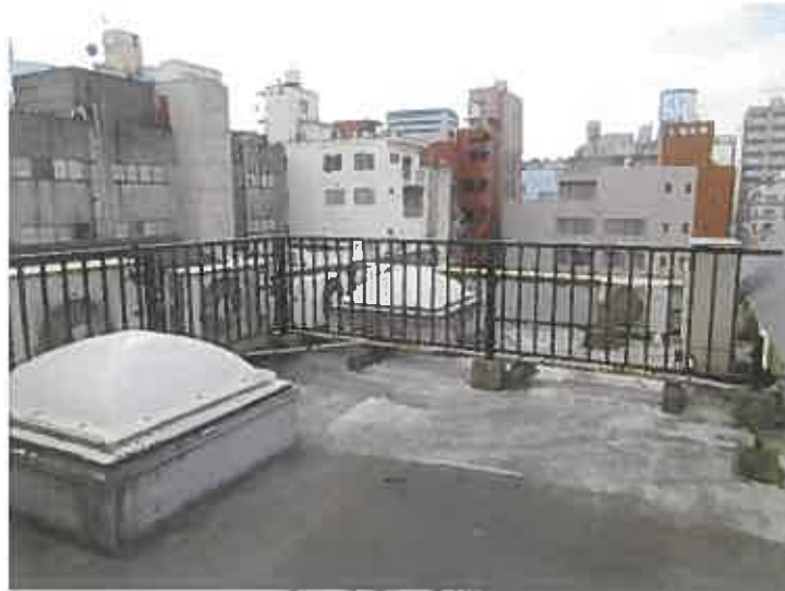
写真⑱ 4階屋上
