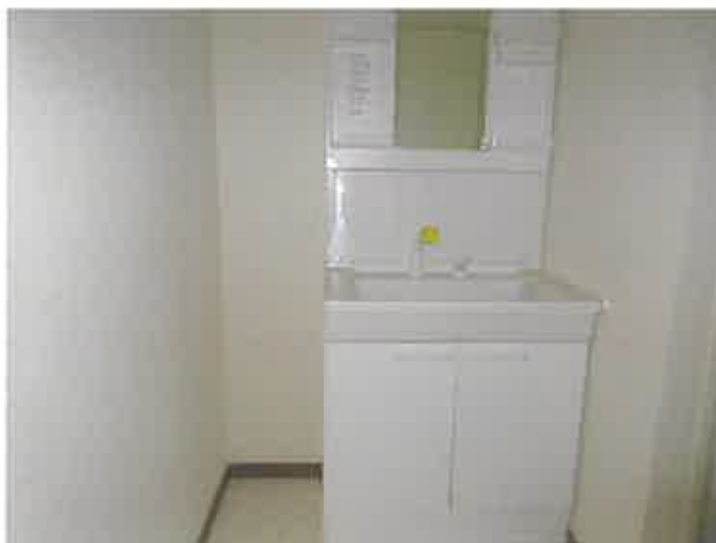
写真⑭建物内部
