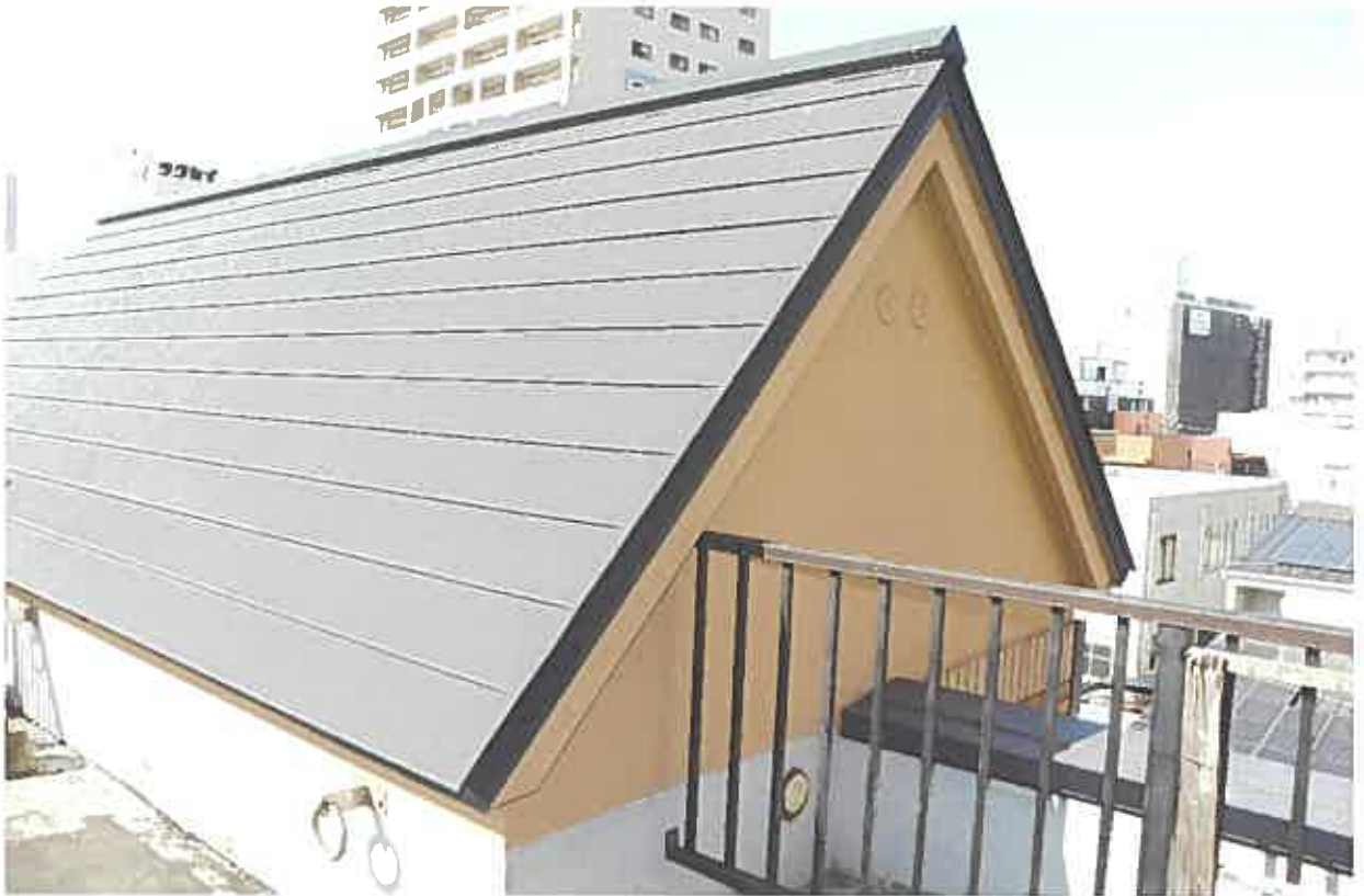
4階屋上；屋根裏部屋の屋根
