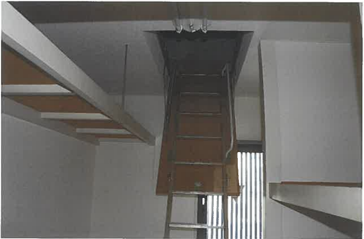
3階；納戸（屋根裏部屋に至る梯子）
