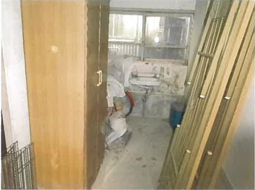
(写真19) 物件2の建物内部
