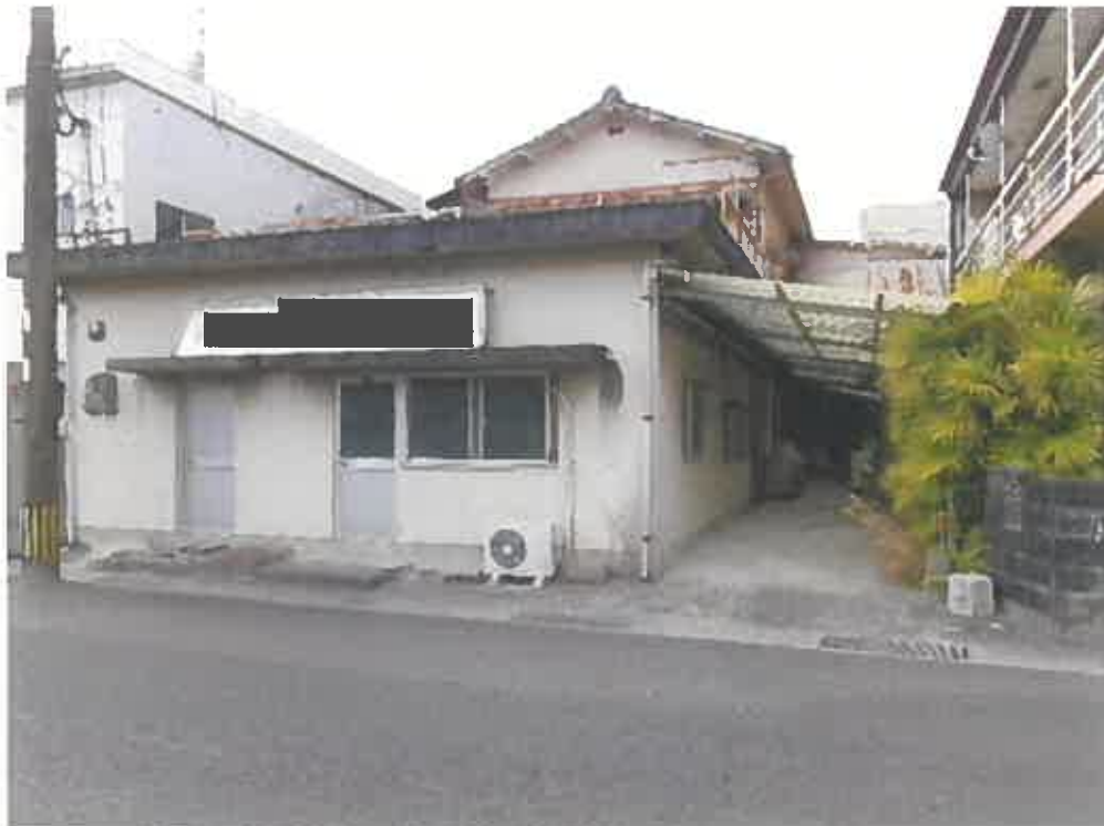
(写真2) 物件2の建物（建物の1階部分のみ）
