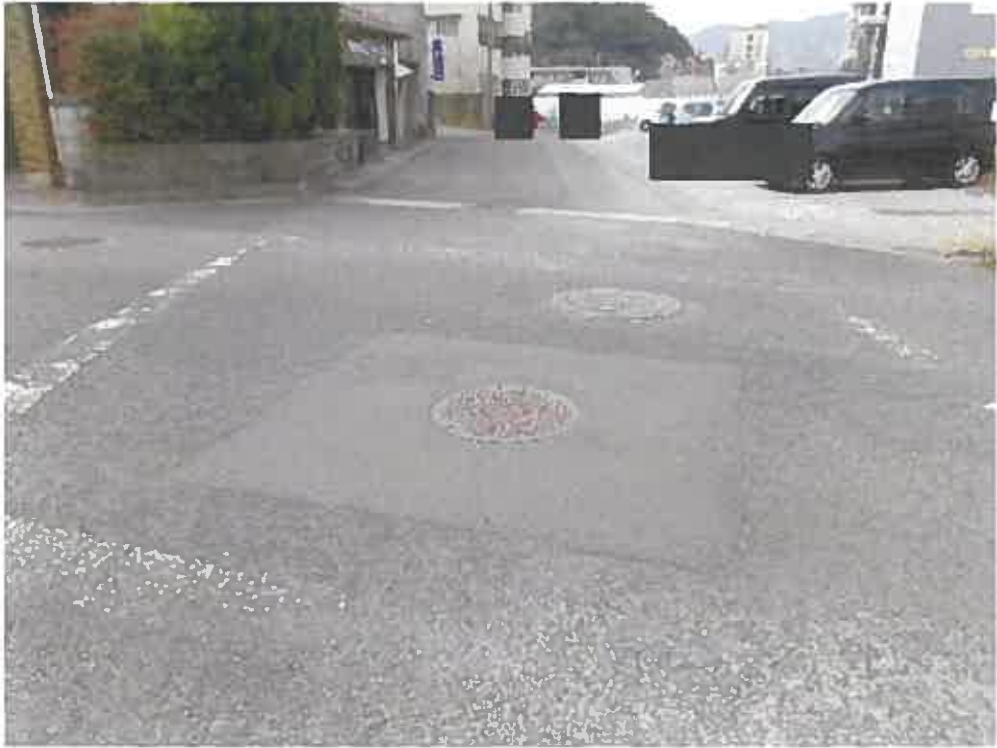
(写真7) 本件土地の接面道路
