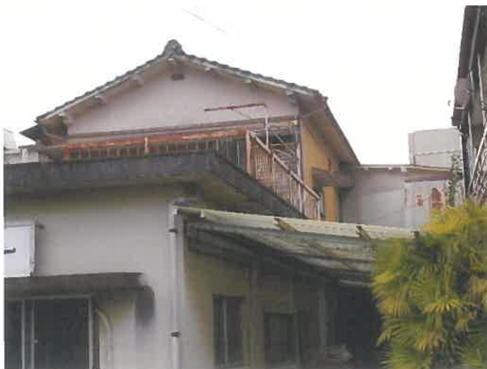
(写真4) 物件3の建物 (建物の2階部分のみ)
