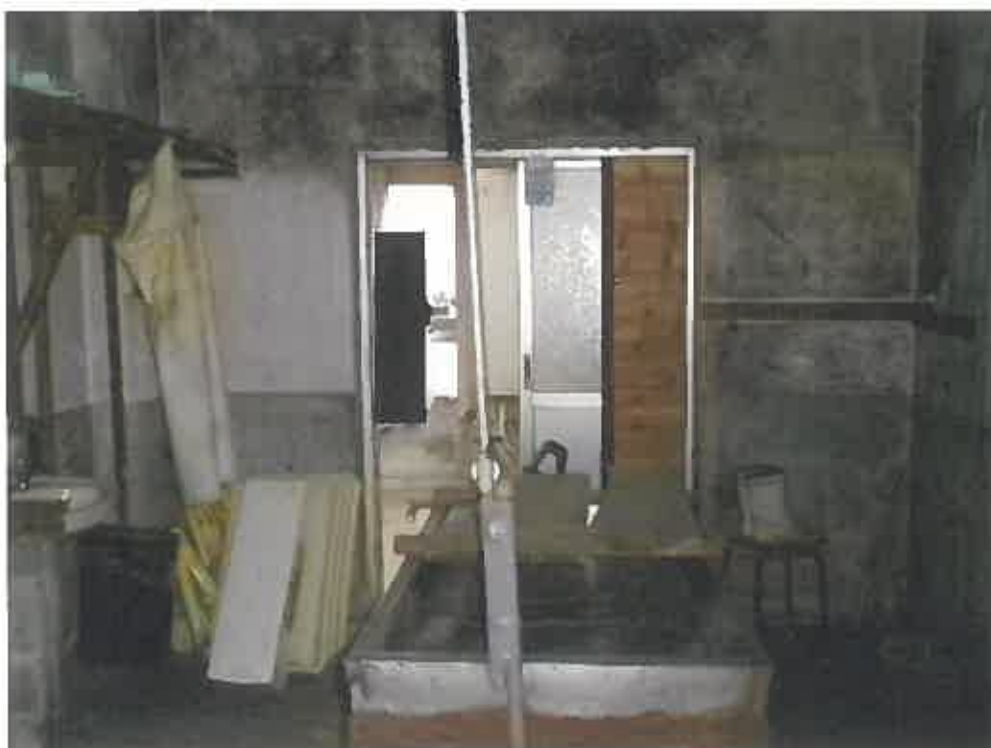
(写真16) 物件2の建物内部
