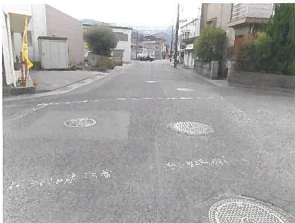
(写真6) 本件土地の接面道路
