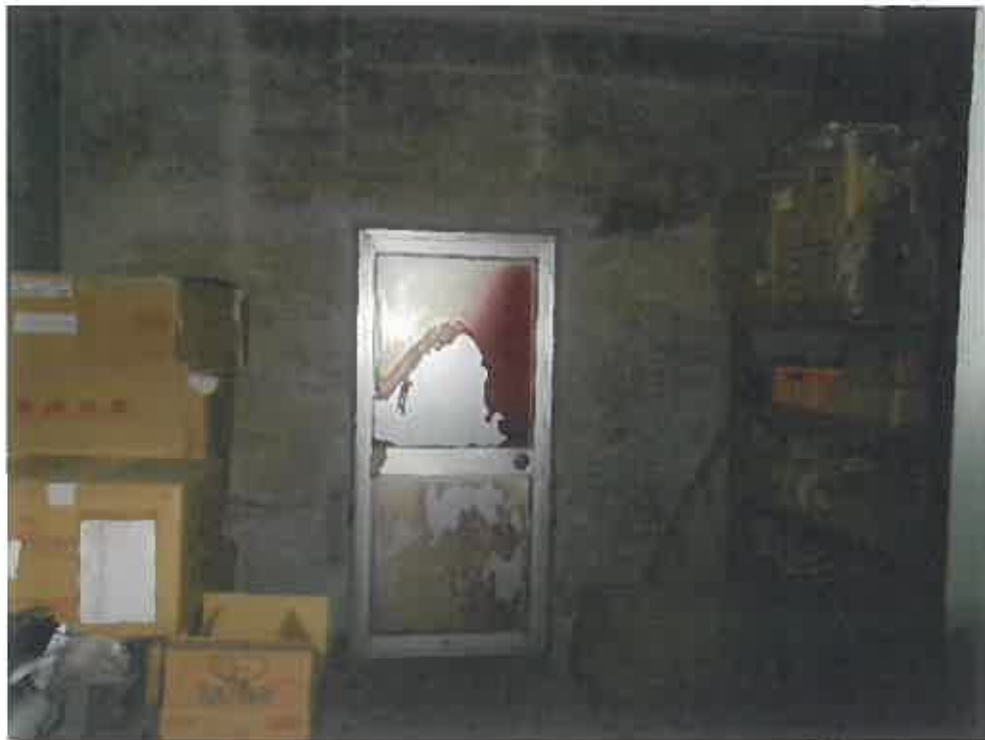
(写真1 2) 物件2の建物内部
