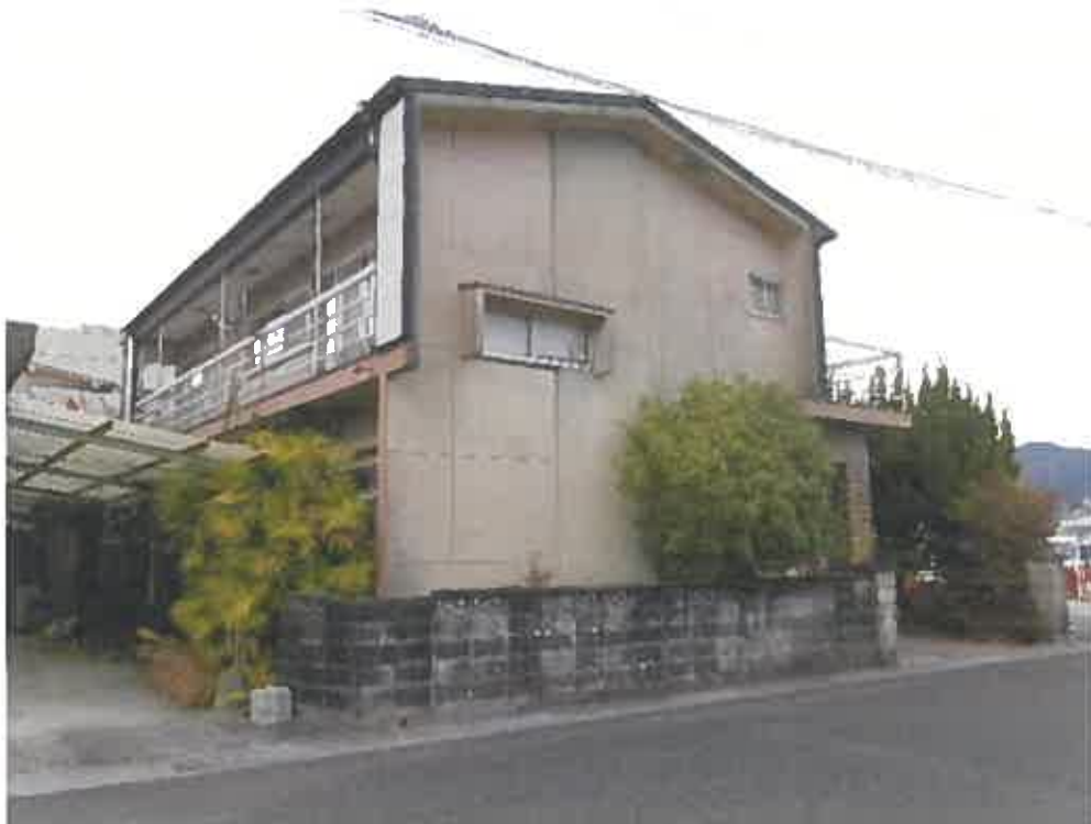
(写真3) 物件3の建物
