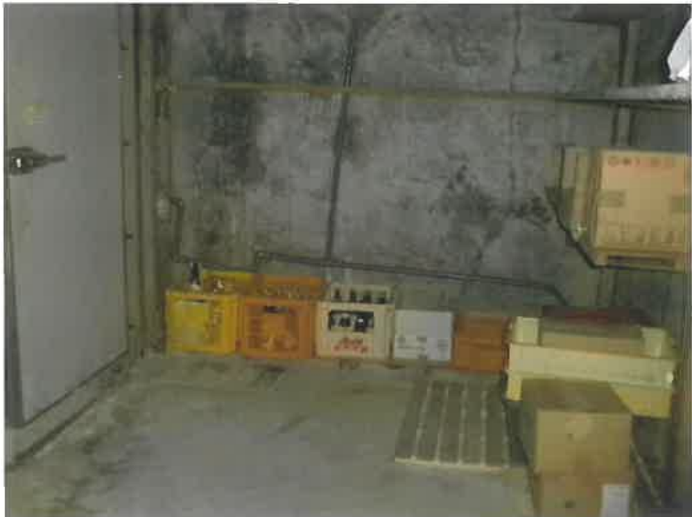
(写真20) 物件3の建物内部(1階)
