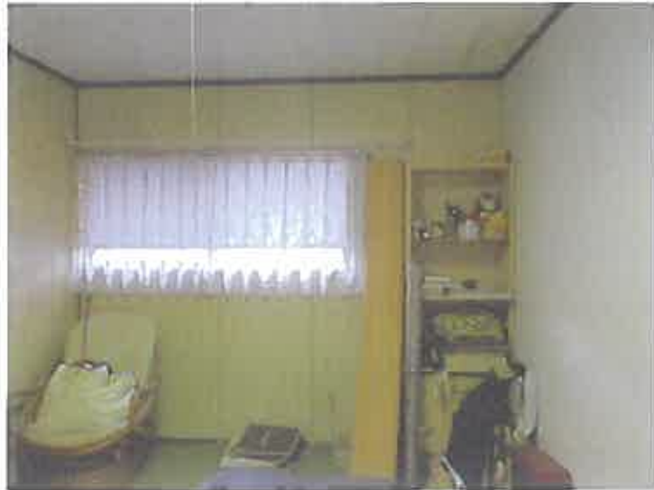
写真⑭建物内部
