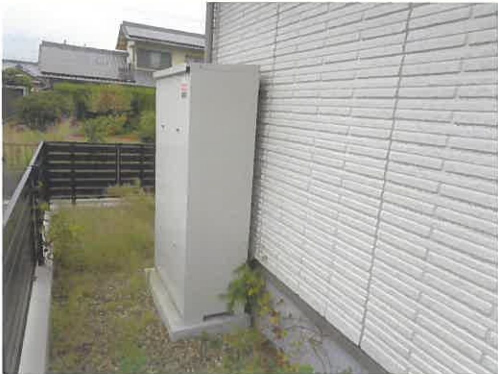
(写真6) 売却対象物件(従物)であるプロパンガス庫
