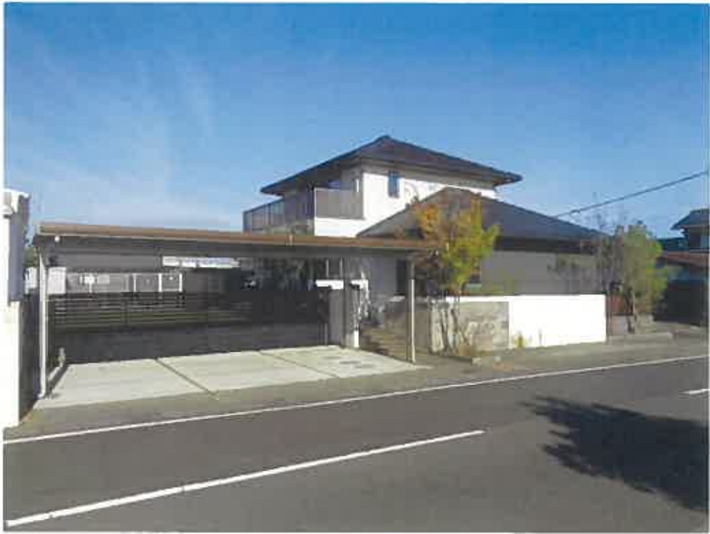
(写真1) 本件土地建物全景
