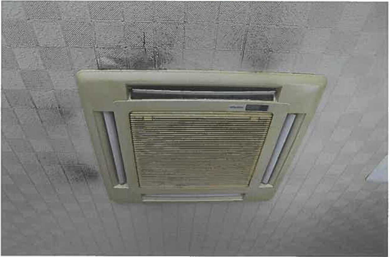
天井クロスの汚損（1階；LDK）
