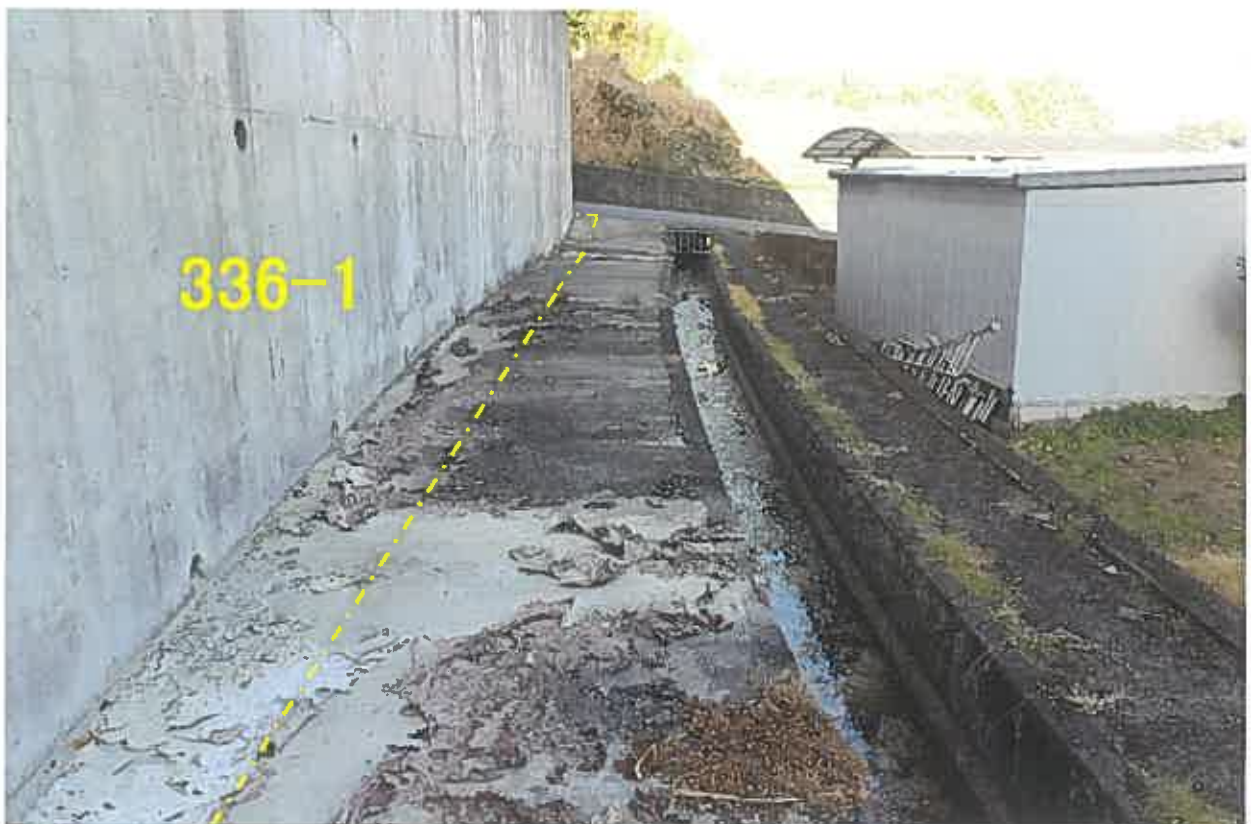
南東側擁壁下の里道・水路
