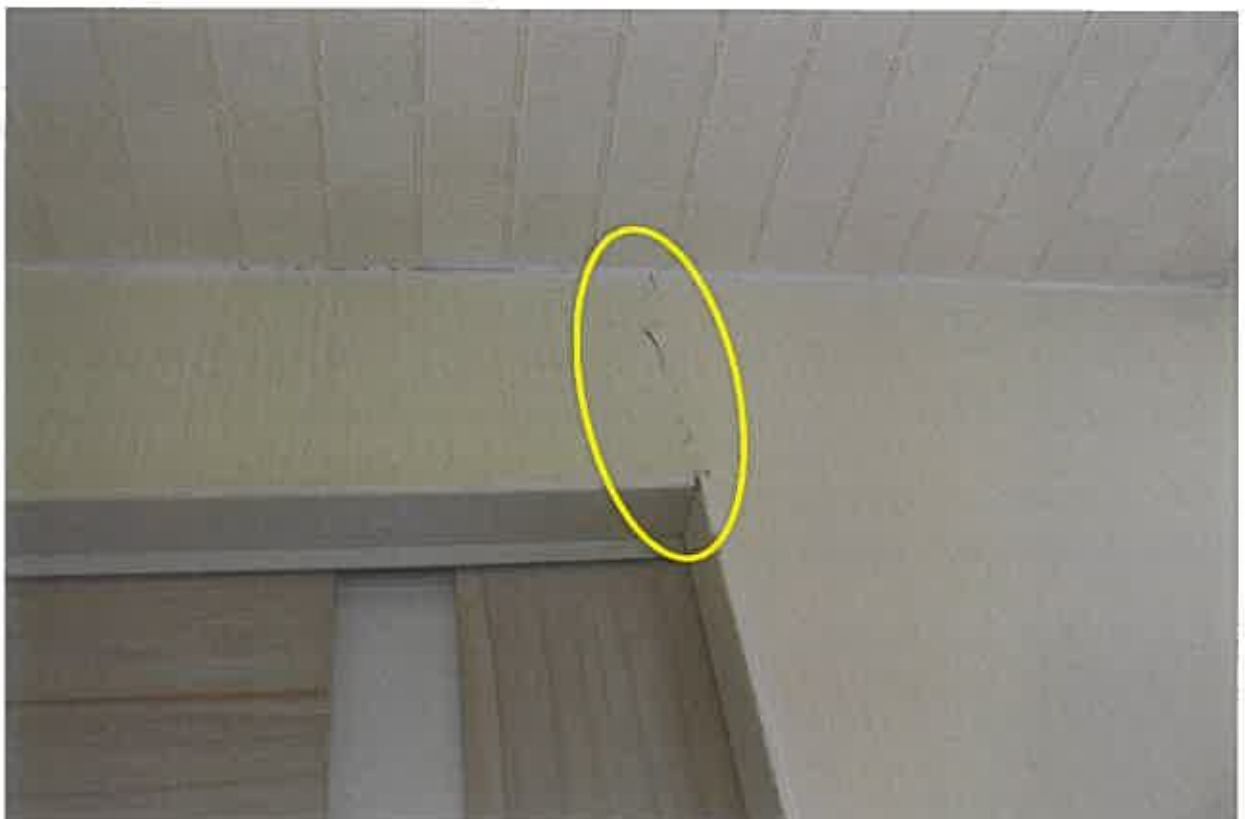
壁クロスの破断（1階；LDK）
