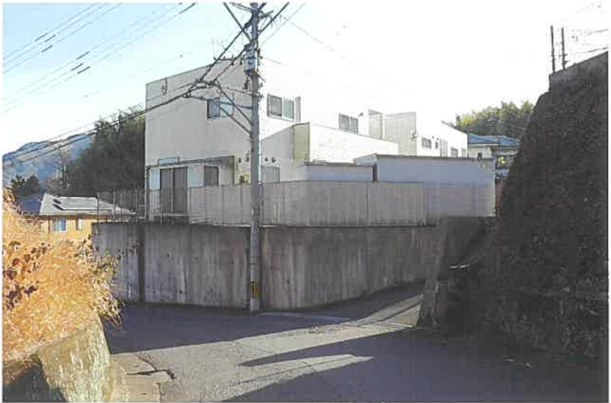
対象物件；北西より
