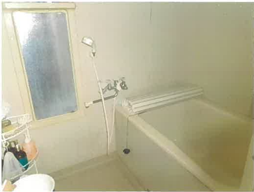
(写真9) 本件建物内部
