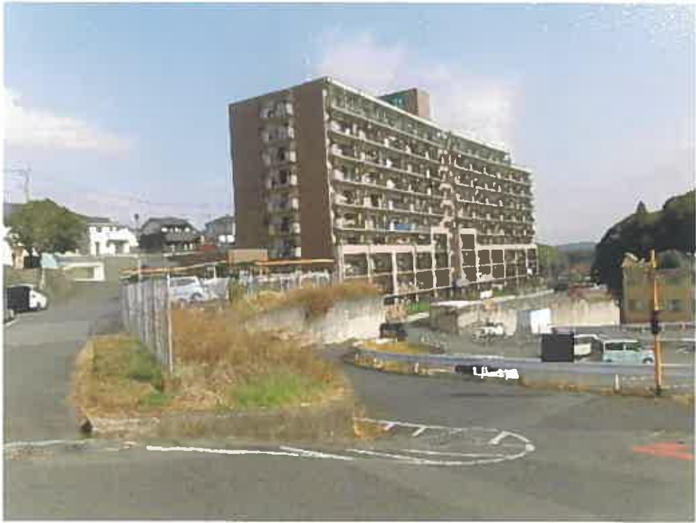
(写真1) 本件1棟の建物全景
