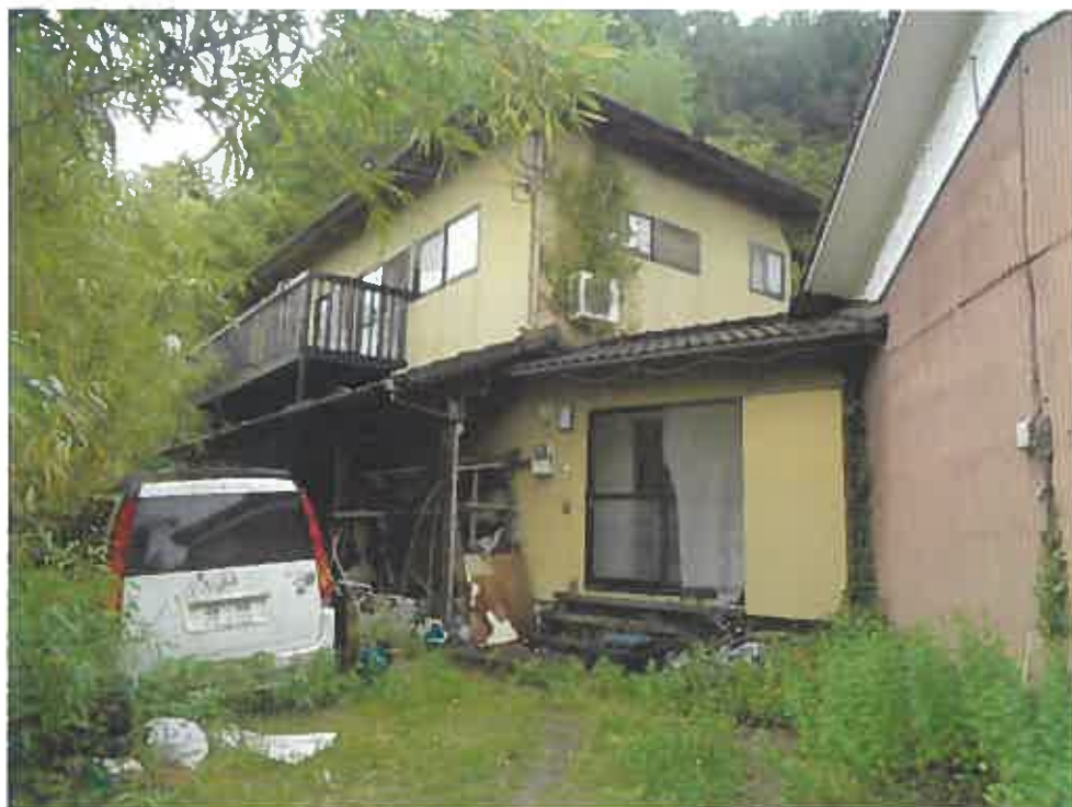
(写真2) 本件建物
