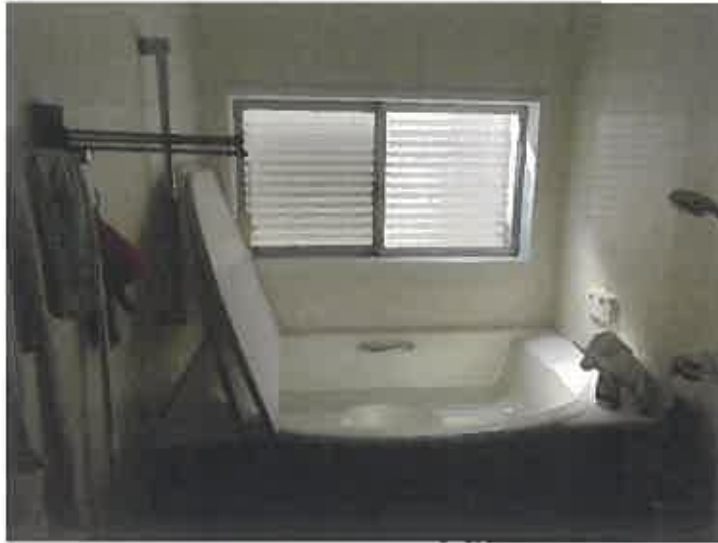
写真⑧建物内部
