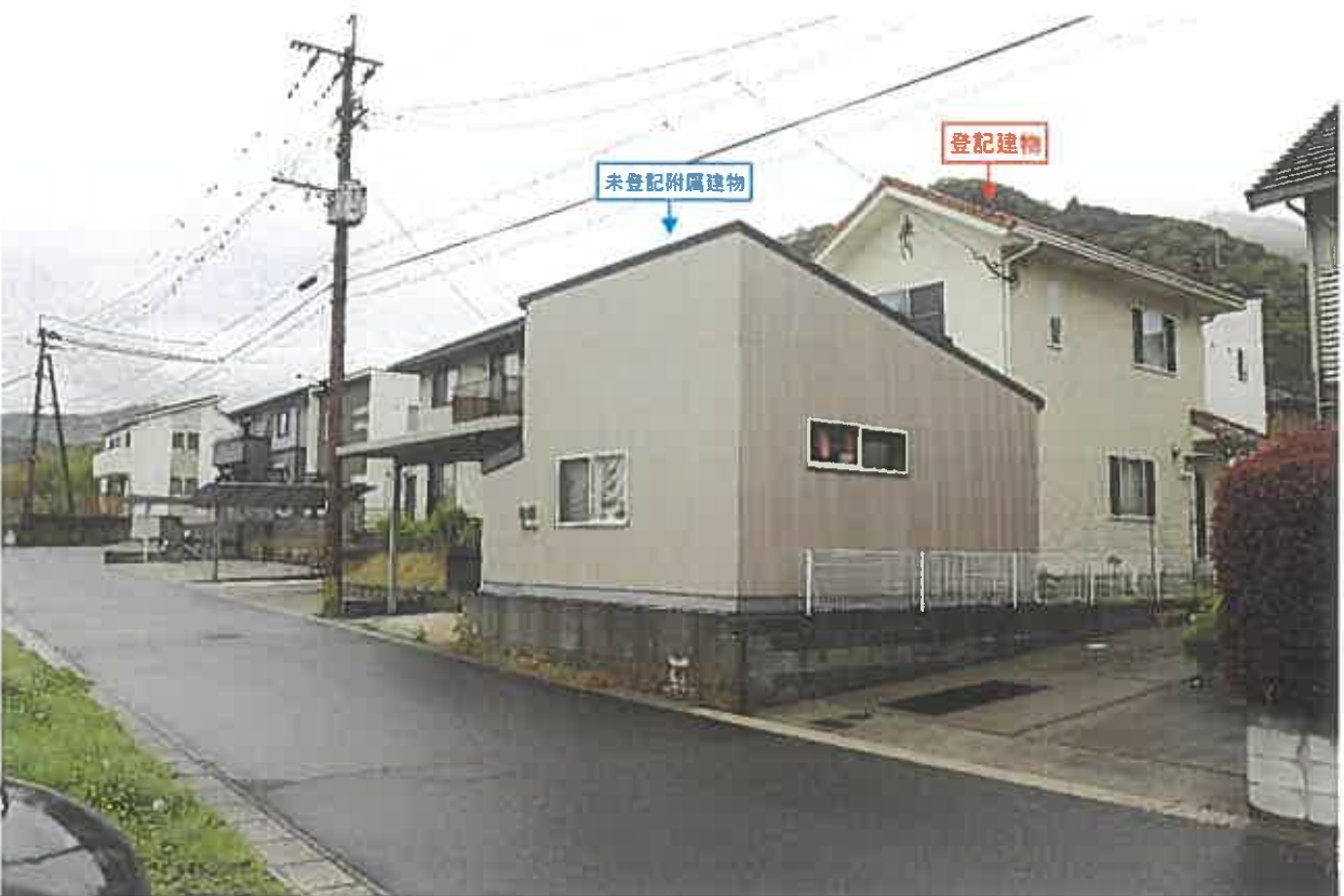
対象物件；東方より
