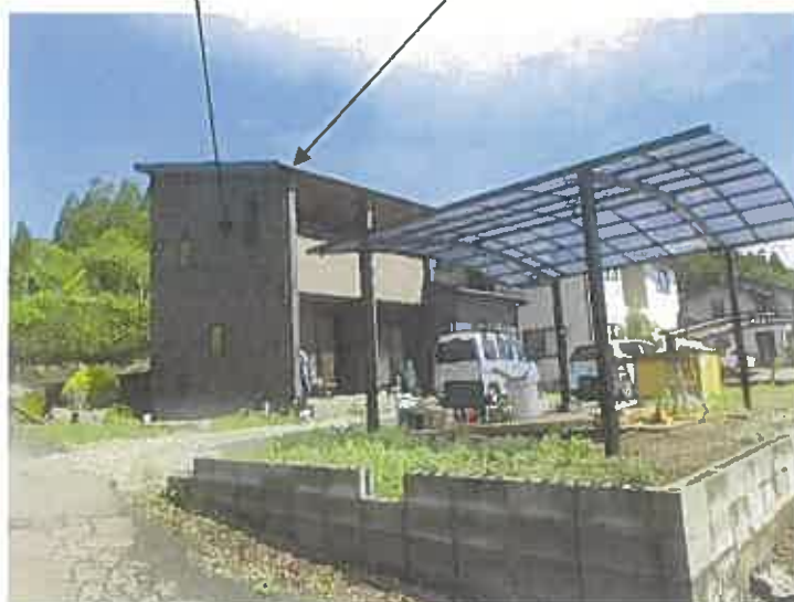
写真②市道 水溜まり ヒートポンプ給湯機
