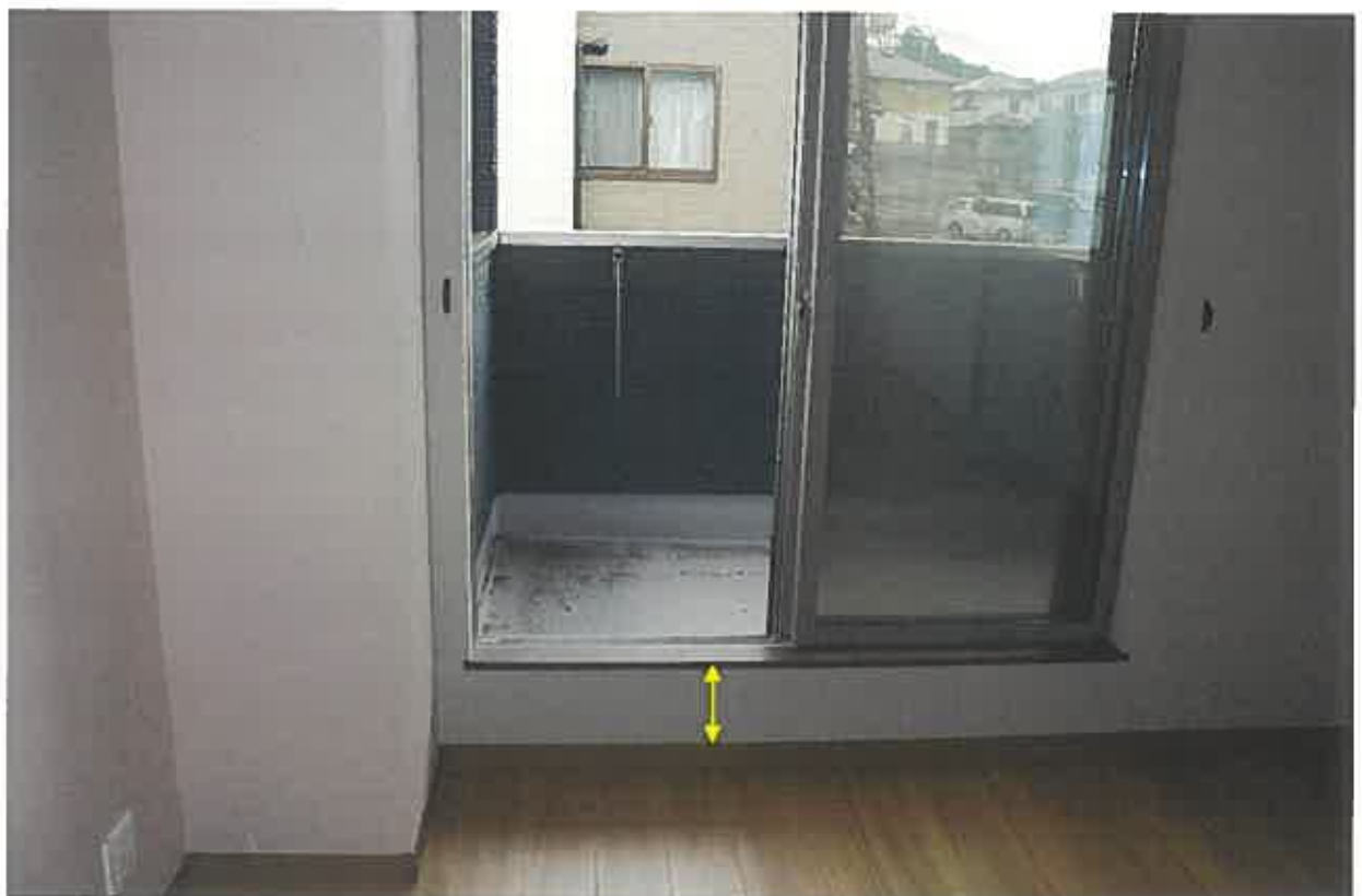
ベランダ出入口 (2階：洋室①)
