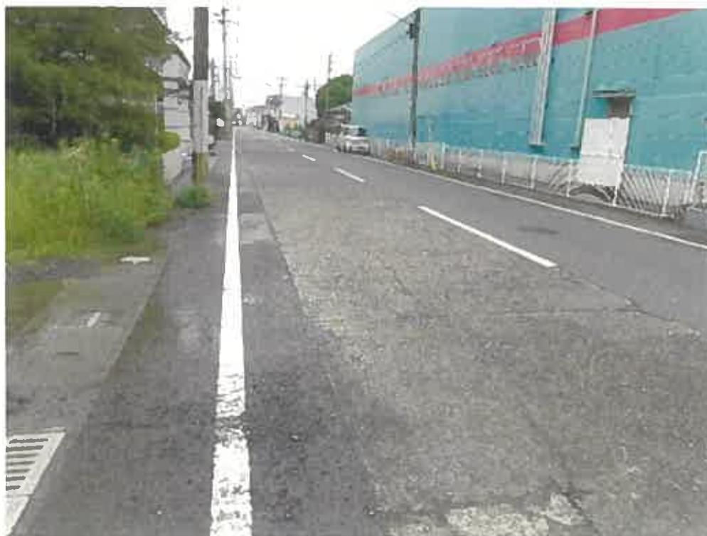
(写真2) 本件土地の接面道路
