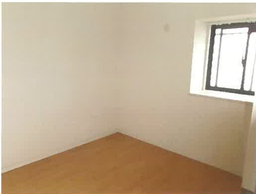
(写真7) 本件建物内部
