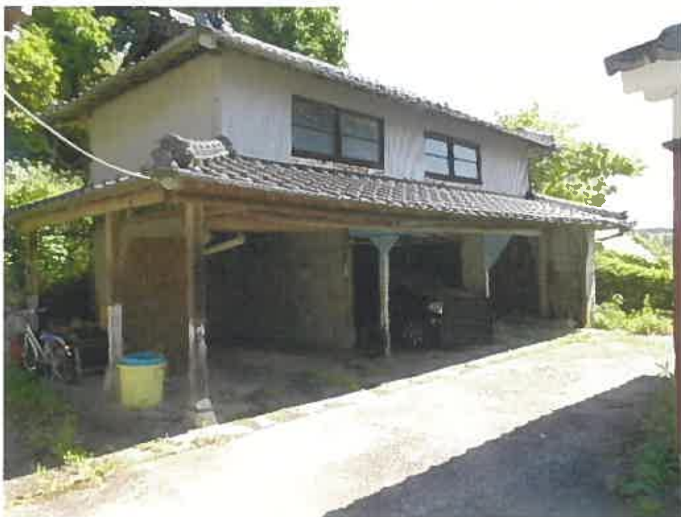
(写真3) 符号1の附属建物
