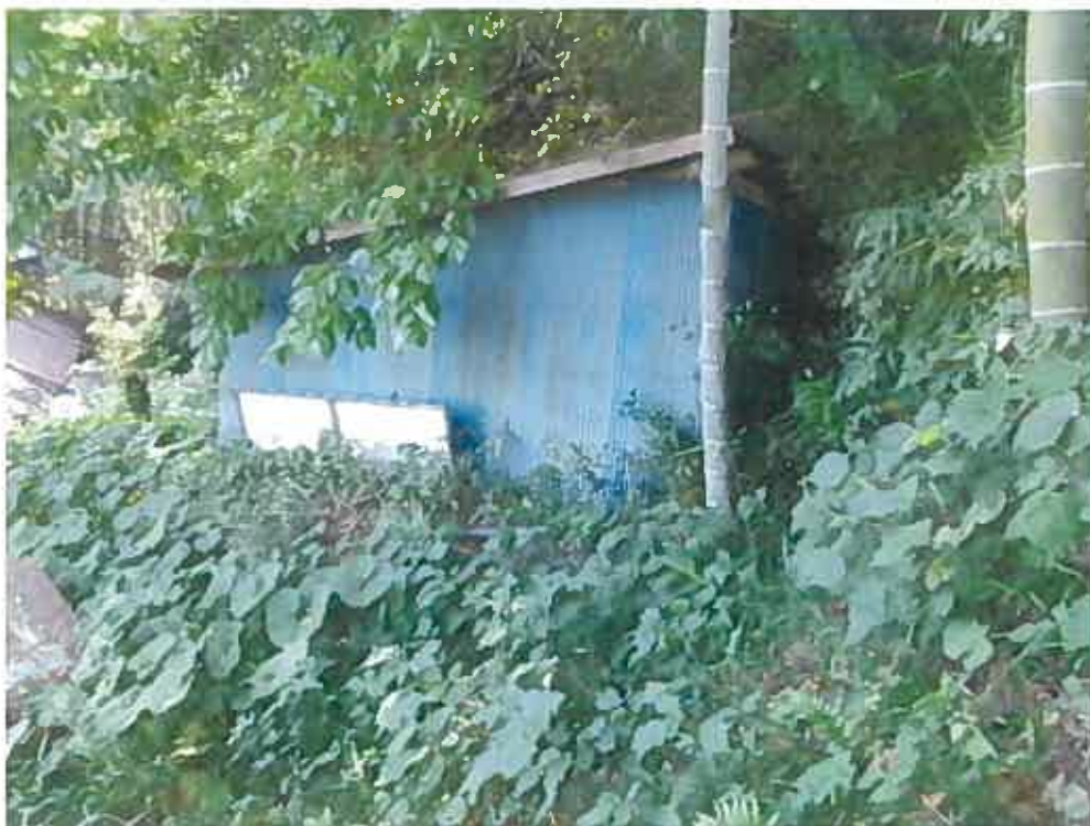
(写真5) 未登記附属建物
