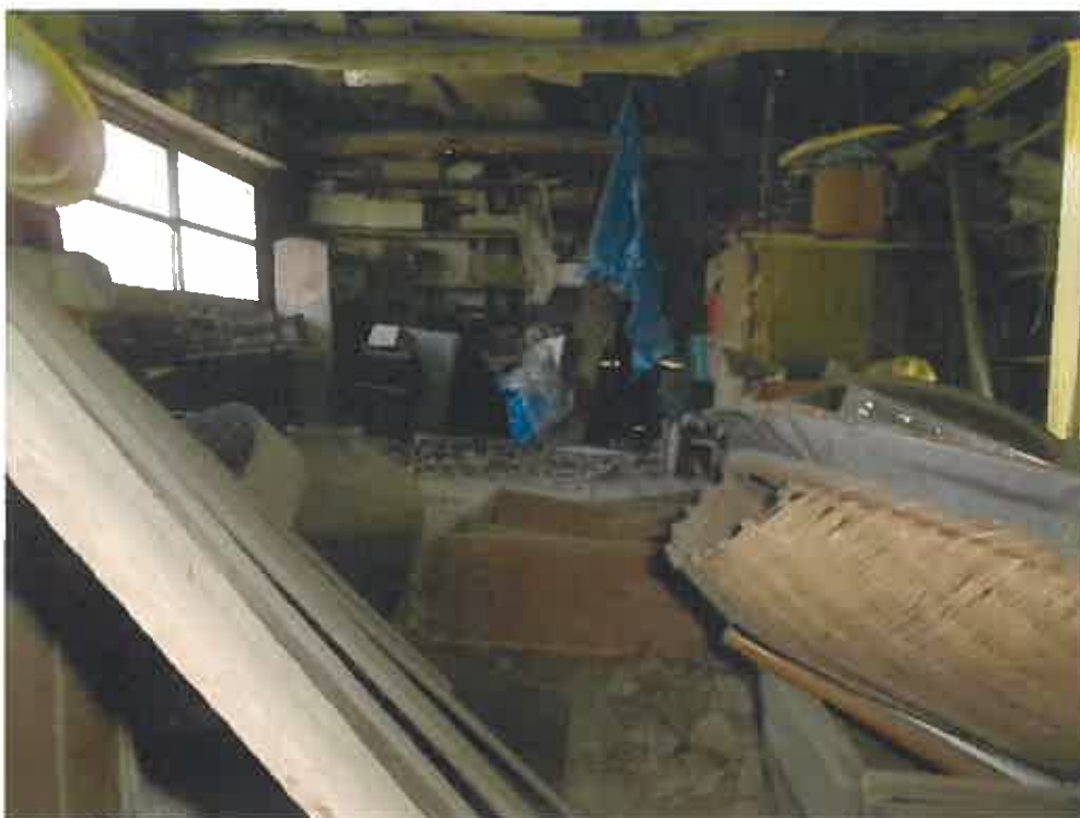
(写真 2 5) 符号 1 の附属建物内部 (2 階)
