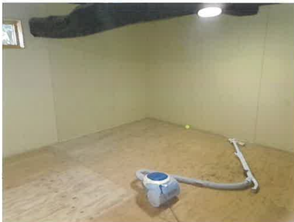
(写真 2 1) 本件主たる建物内部 (2 階)
