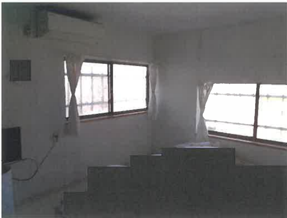
(写真 17) 本件主たる建物内部 (1 階)
