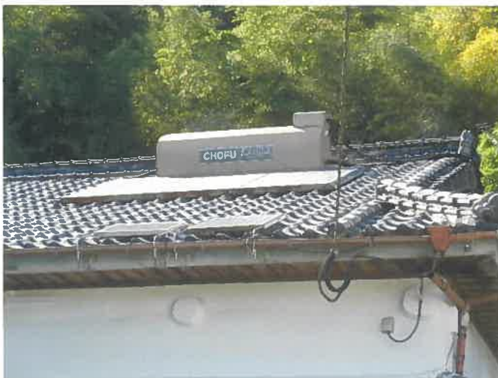
(写真8) 本件建物の従物である太陽熱温水器
