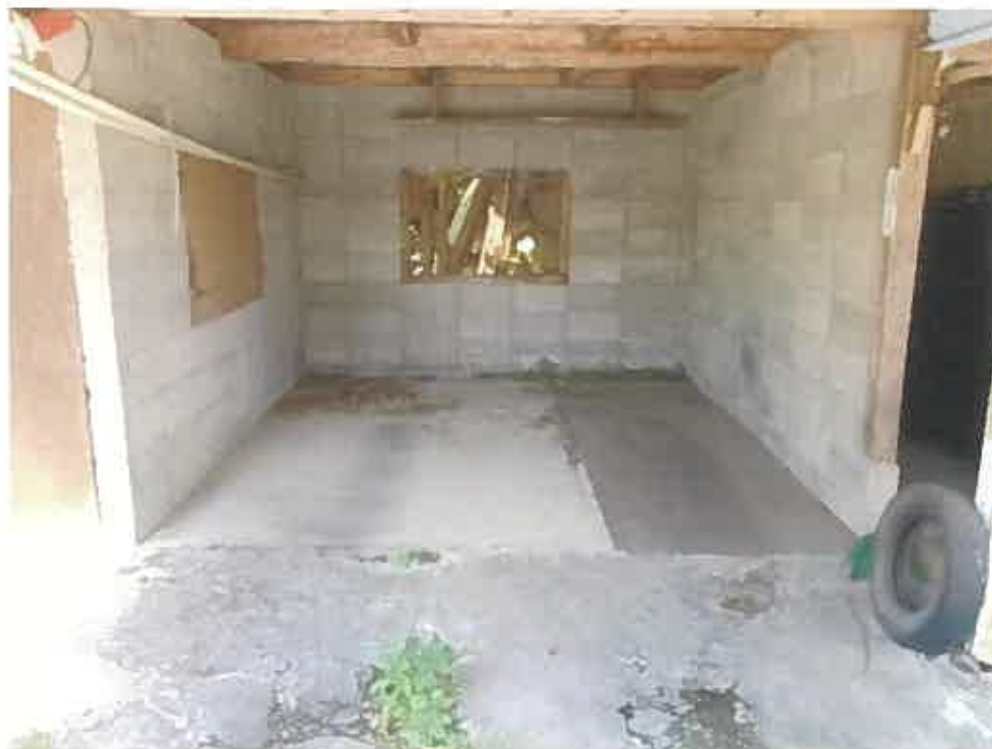
(写真 2 2) 符号 1 の附属建物内部 (1 階)
