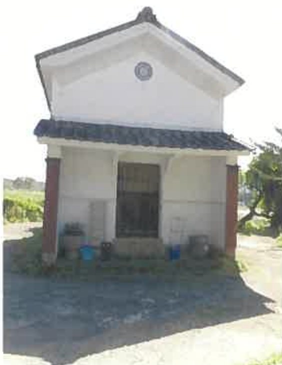
(写真4) 符号2の附属建物
