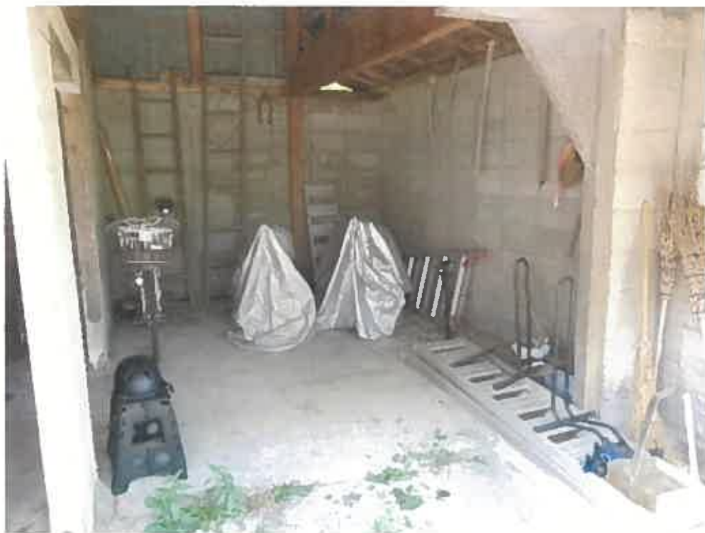
(写真 2 4) 符号 1 の附属建物内部 (1 階)
