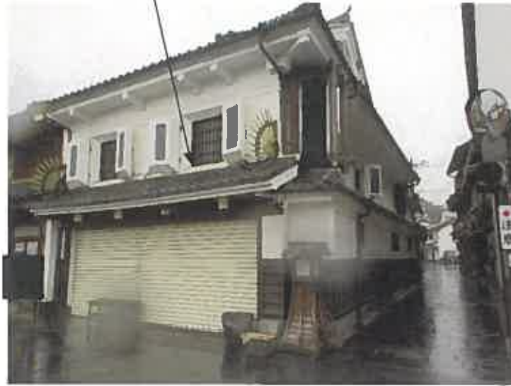
写真②目的の外建物 1
