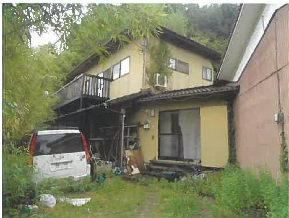
(写真2) 本件建物
