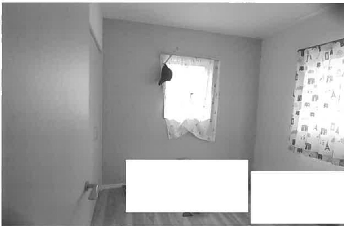
(写真⑪) 本件建物の内部
