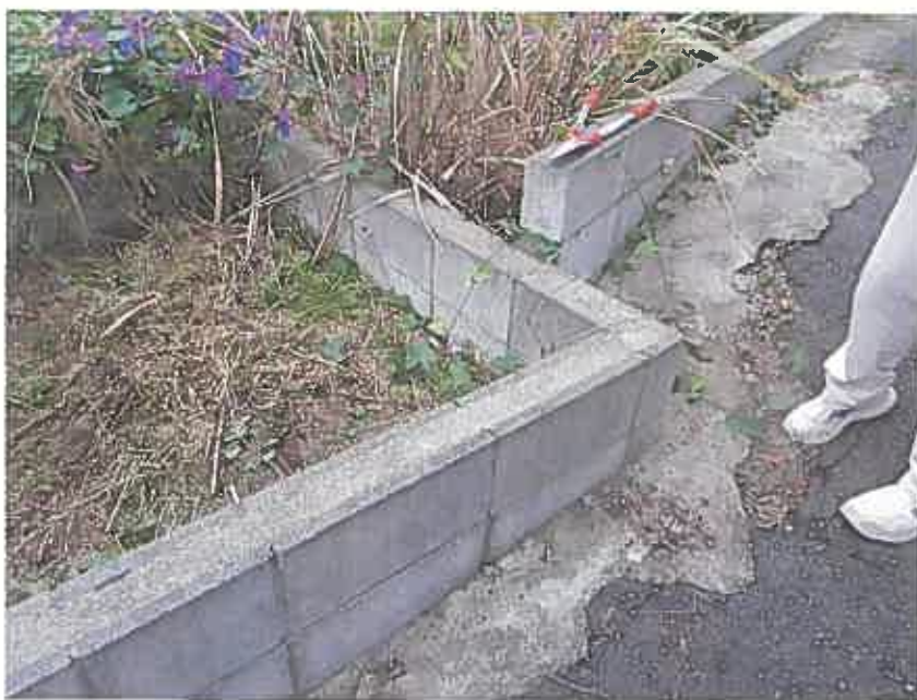
物件 6 鉾泉地と里道部分
