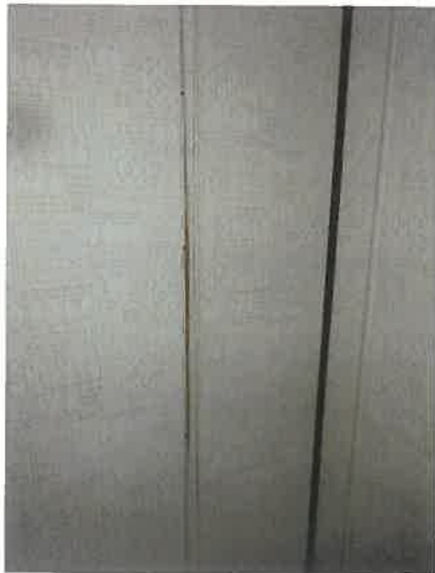
物件3（建物）内部 2階 洋室内壁のクロス剥離
