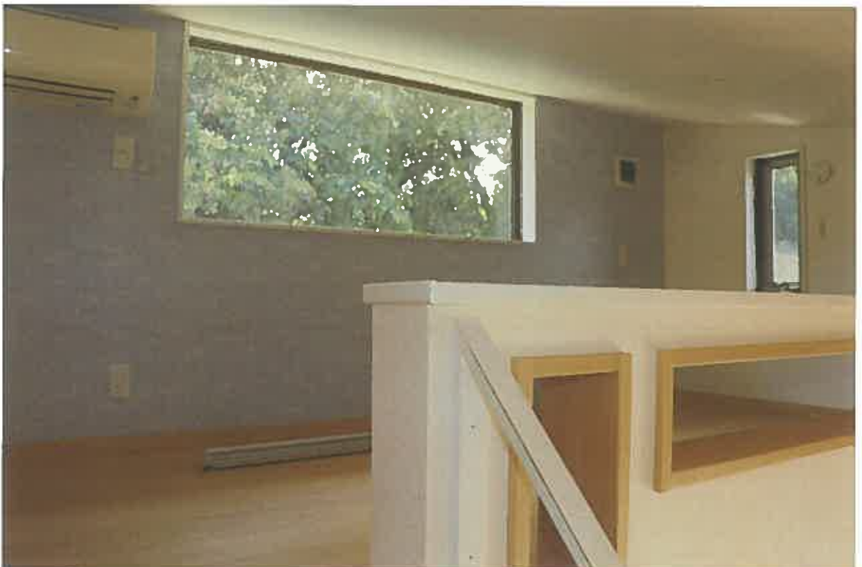
増築部分（洋室④のロフト）
