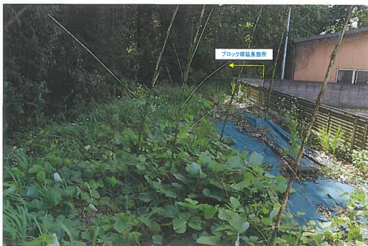
敷地南西側のブロック塀（越境箇所）
