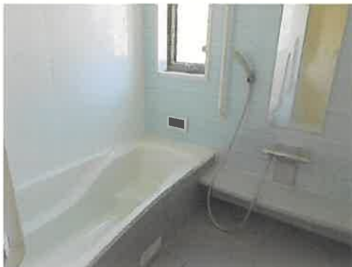
写真⑧建物内部
