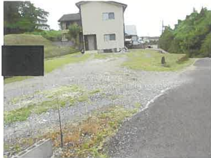
写真⑤目的外土地 1 の排水管
