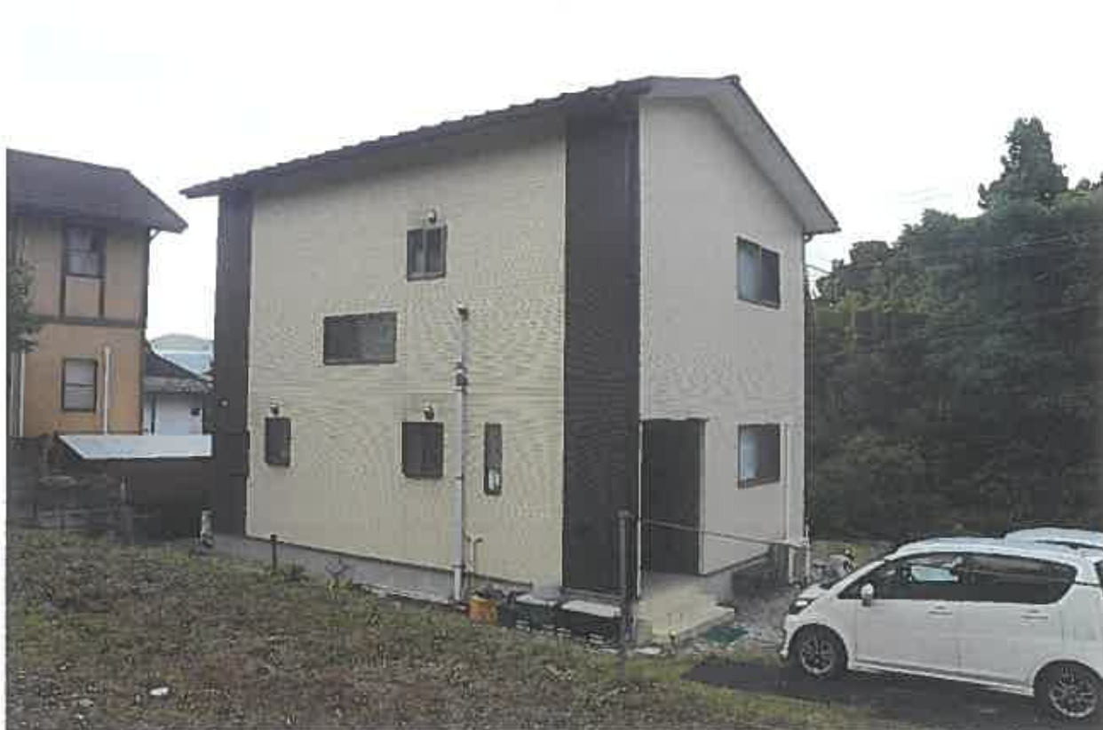
物件3；南方より
