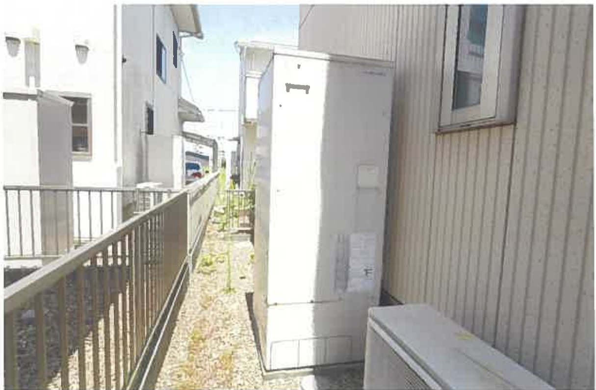
(写真④) 売却対象工作物電気温水器の外景
