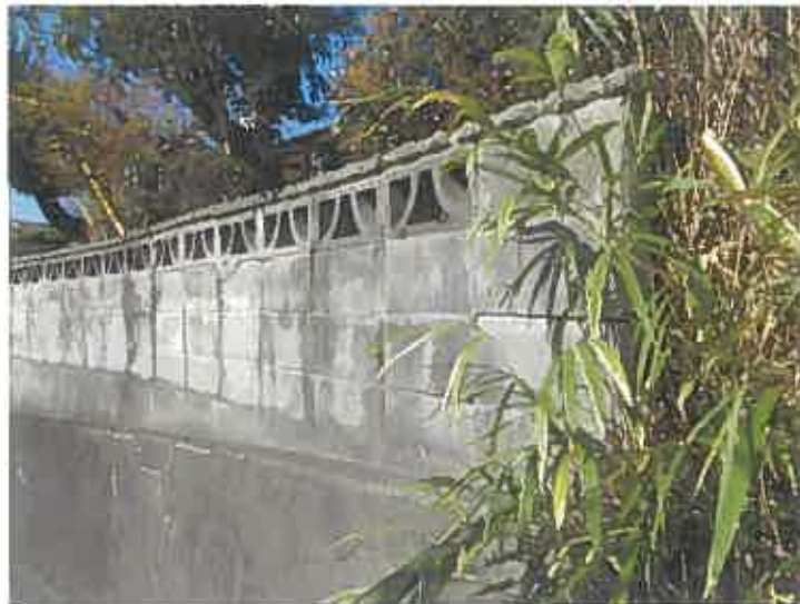
写真③コンクリートブロック擁壁の状況
