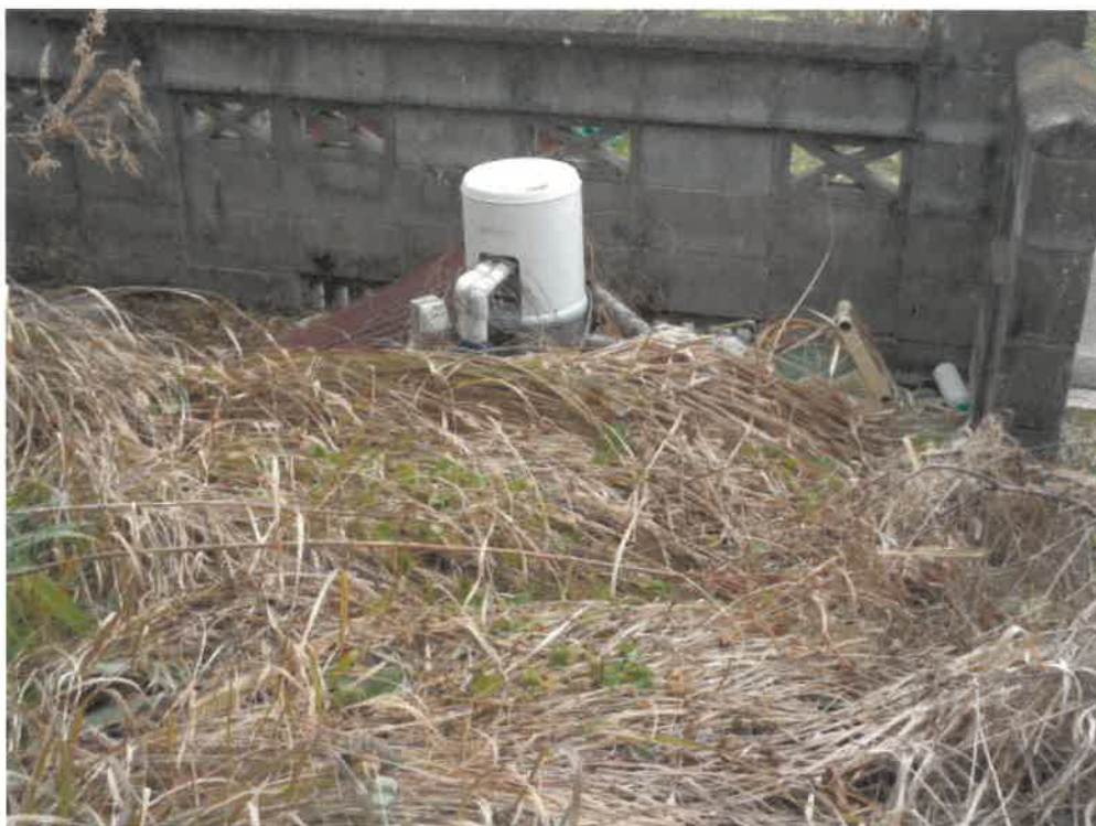
(写真 3) 本件土地に掘削されたボーリング井戸
