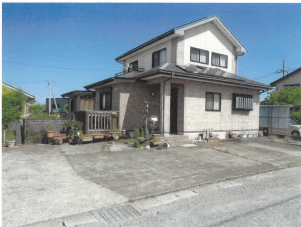
(写真1) 物件1及び4の土地建物全景
