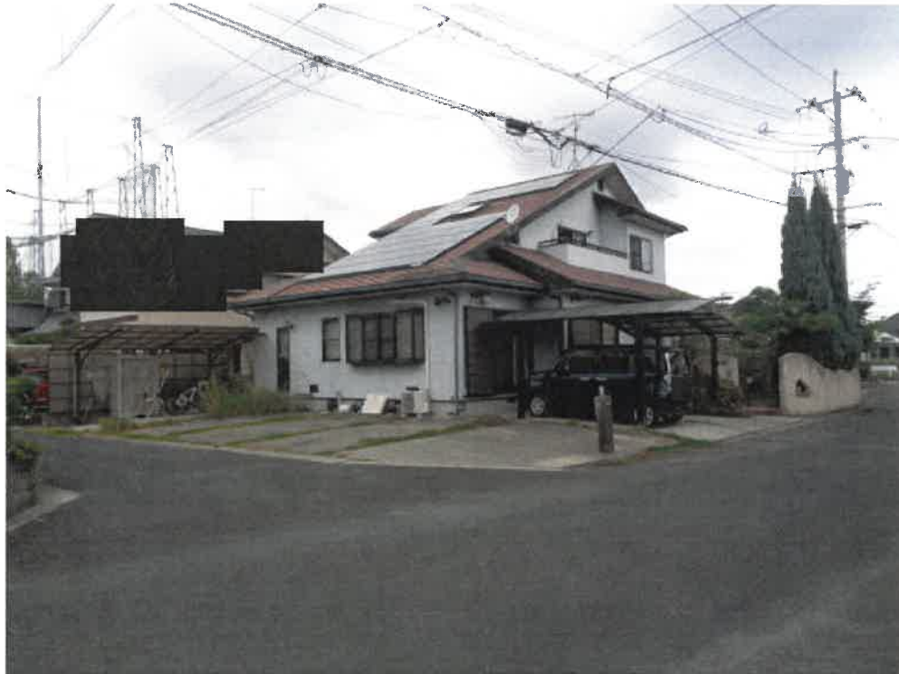
(写真1) 物件1及び8の土地建物全景
