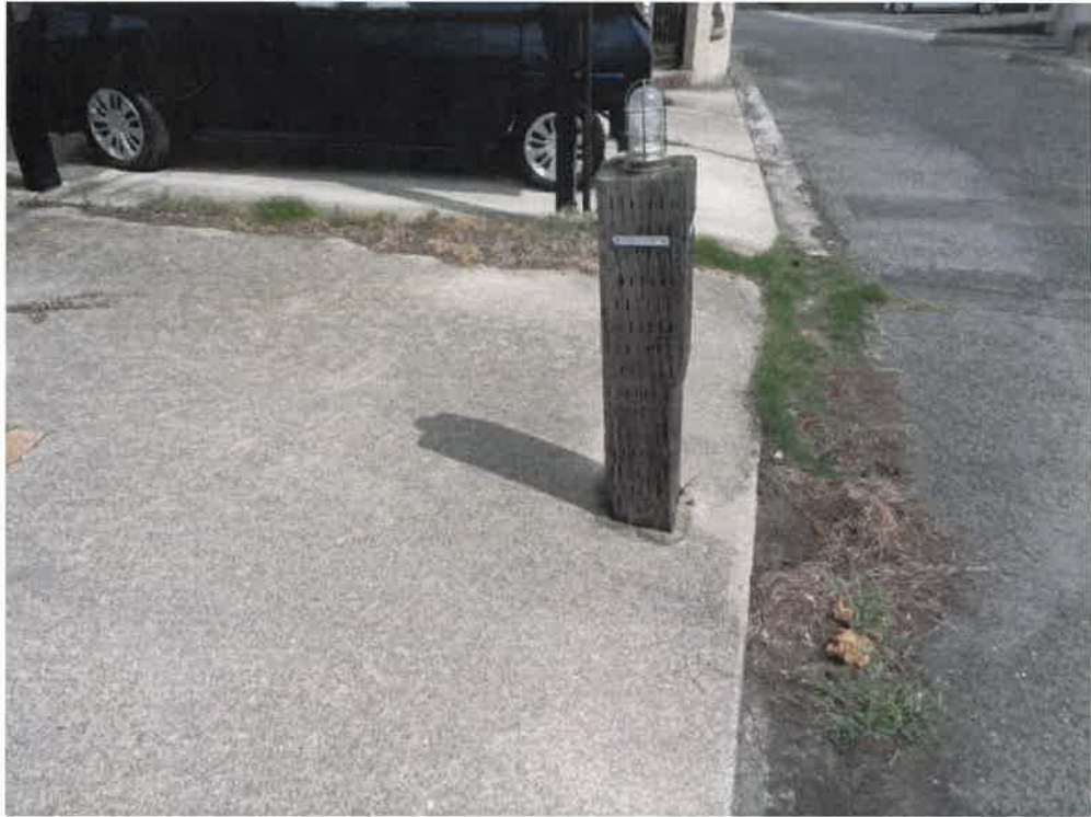
(写真 1 3) 売却対象物件 (従物) である外灯
