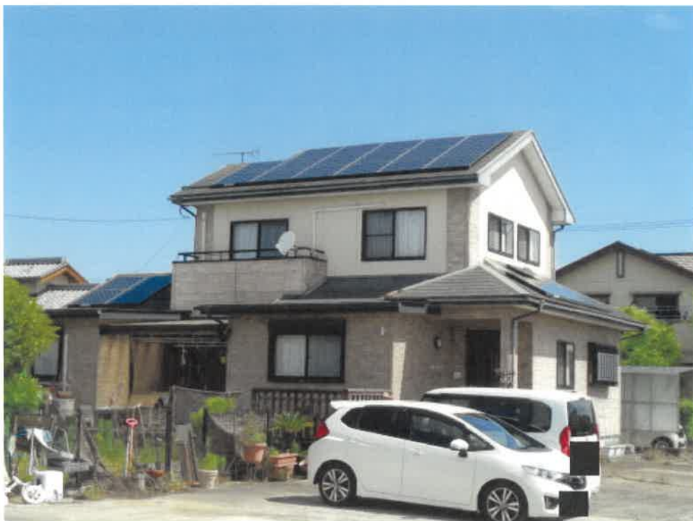
(写真2) 物件4の建物に設置されている太陽光発電パネル
