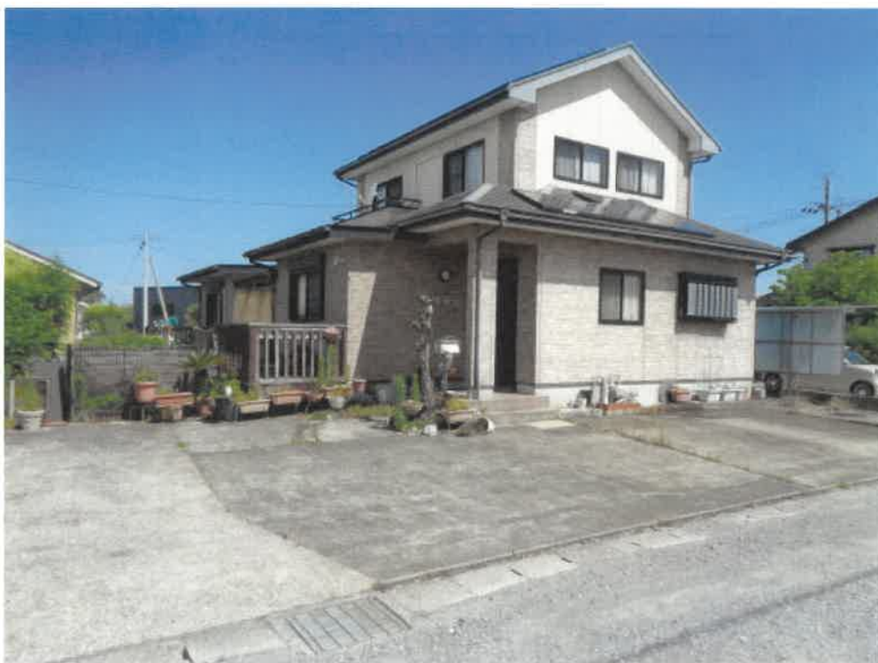
(写真1) 物件1及び4の土地建物全景
