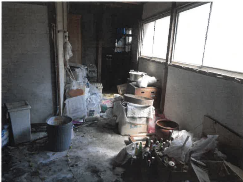
(写真 1 4) 符号 4 の附属建物内部 (1 階)
