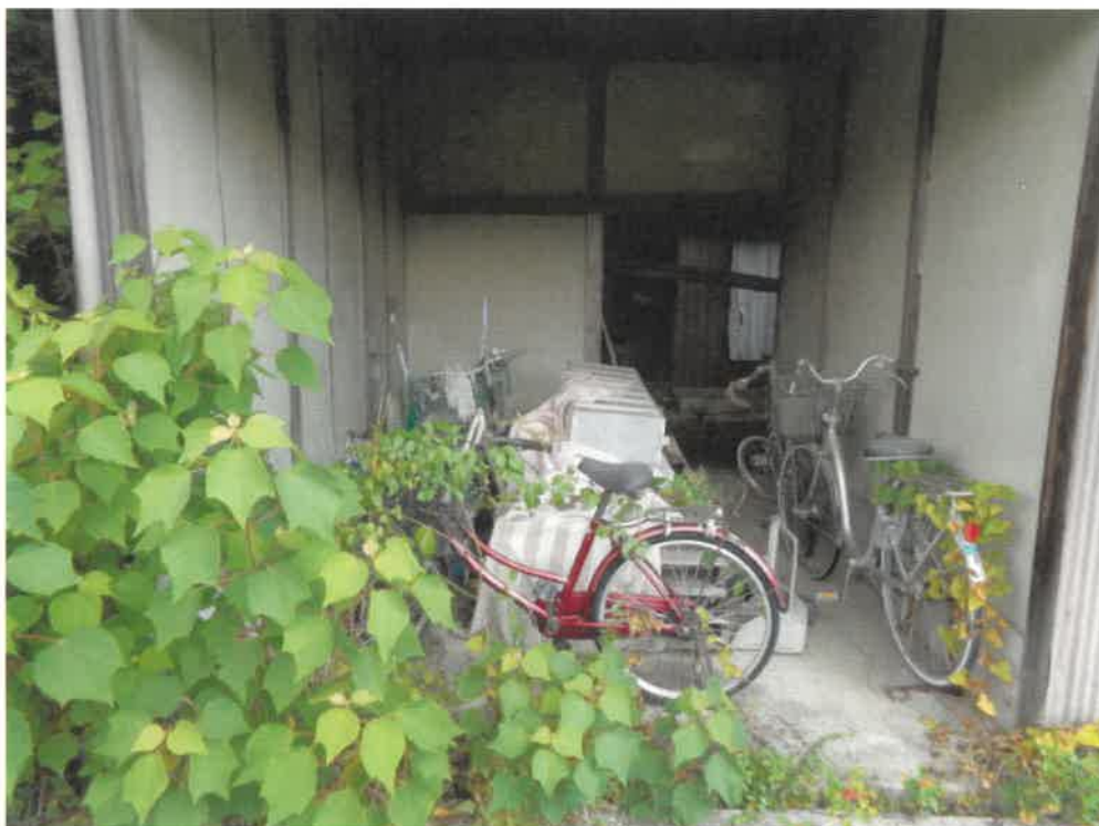
(写真 2 0) 符号 3 の附属建物内部
