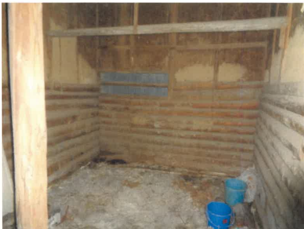
(写真 2 1) 符号 3 の附属建物内部
