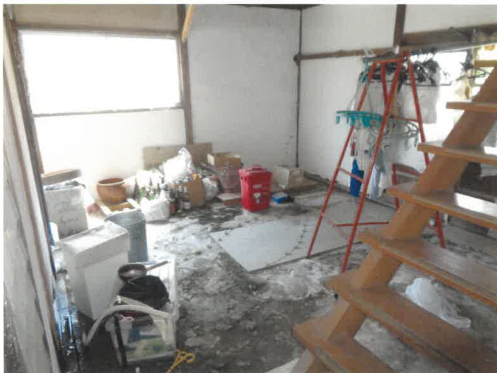
(写真 1 3) 符号 4 の附属建物内部 (1 階)
