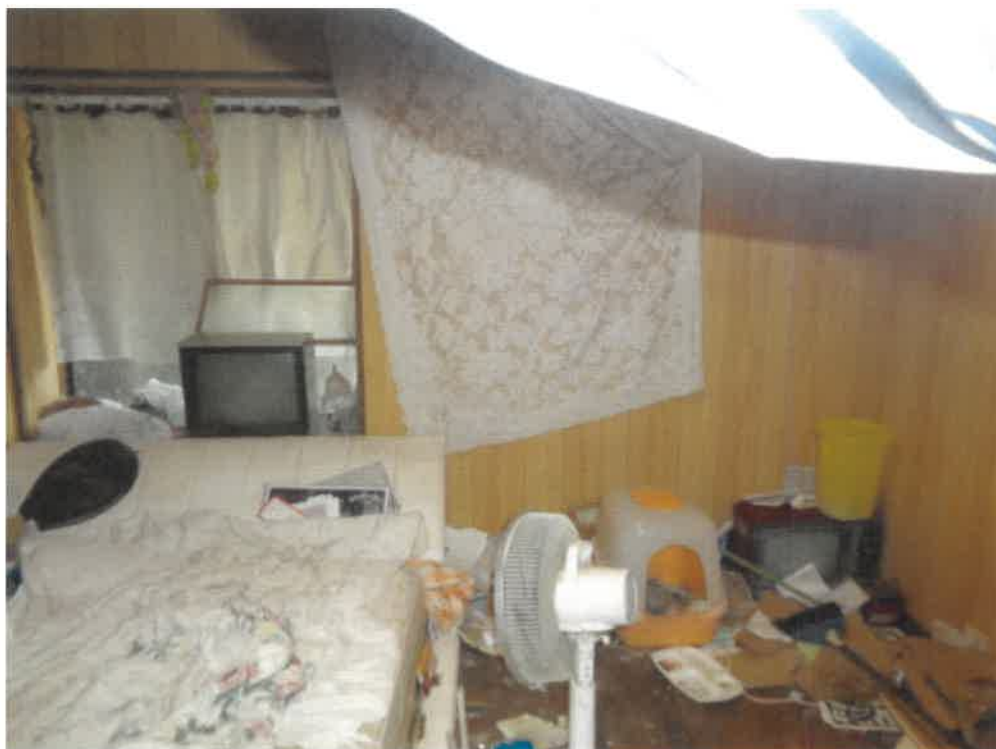
(写真 1 2) 符号 4 の附属建物内部 (1 階)
