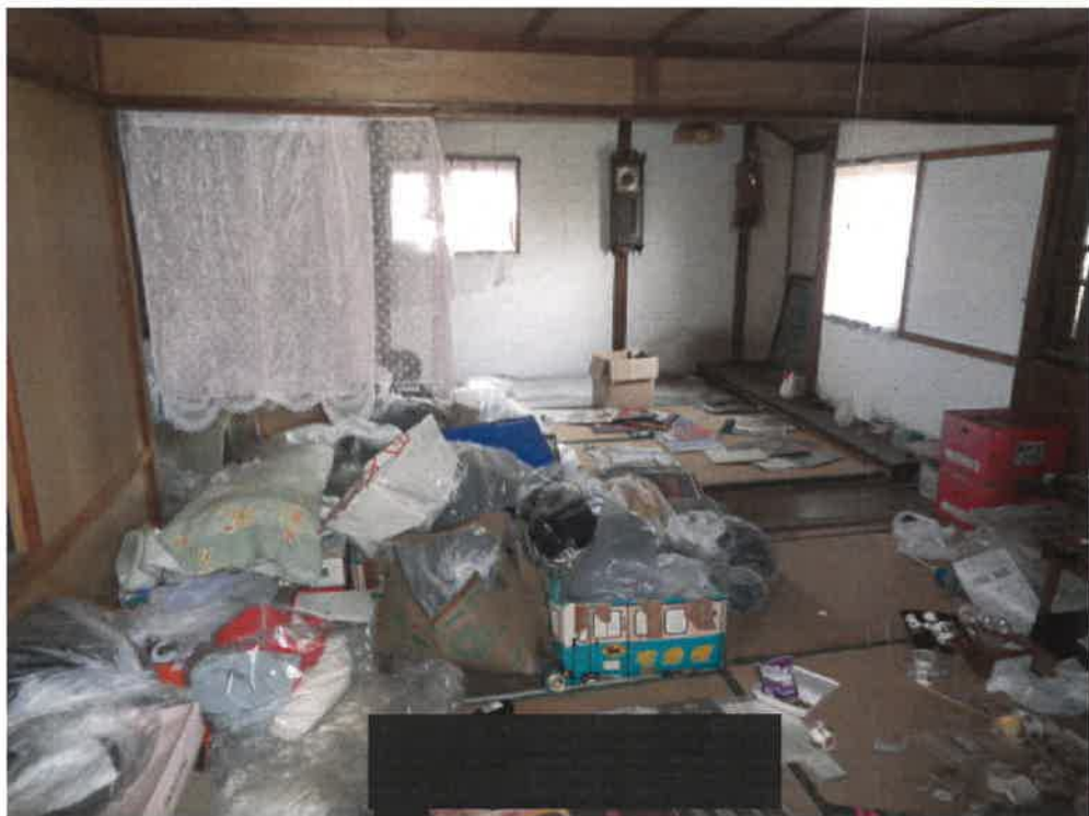
(写真 1 5) 符号 4 の附属建物内部 (2 階)
