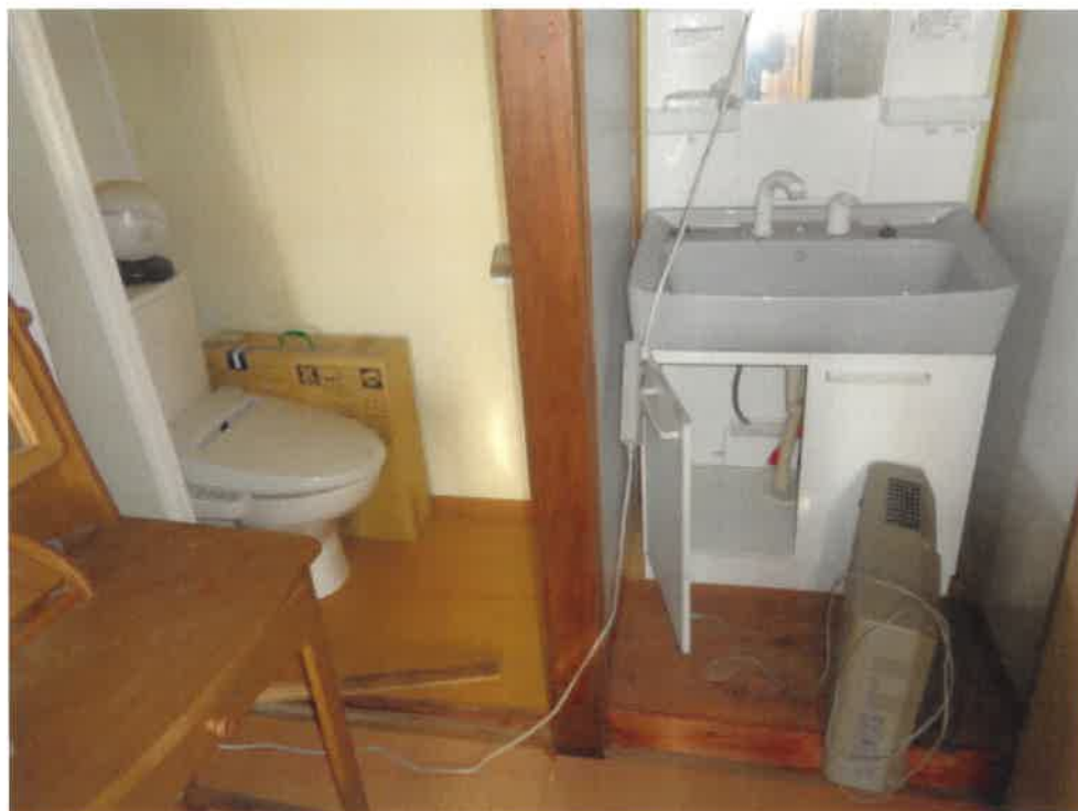
(写真5) 本件建物内部 (トイレ・洗面所)
