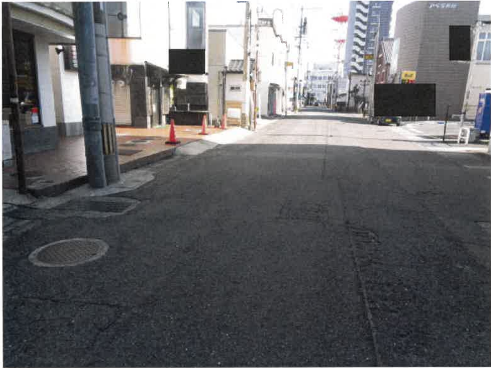
(写真2) 本件各土地の接面道路
