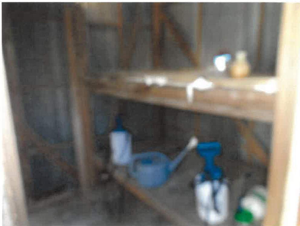
(写真 1 1) 符号 1 の附属建物内部
