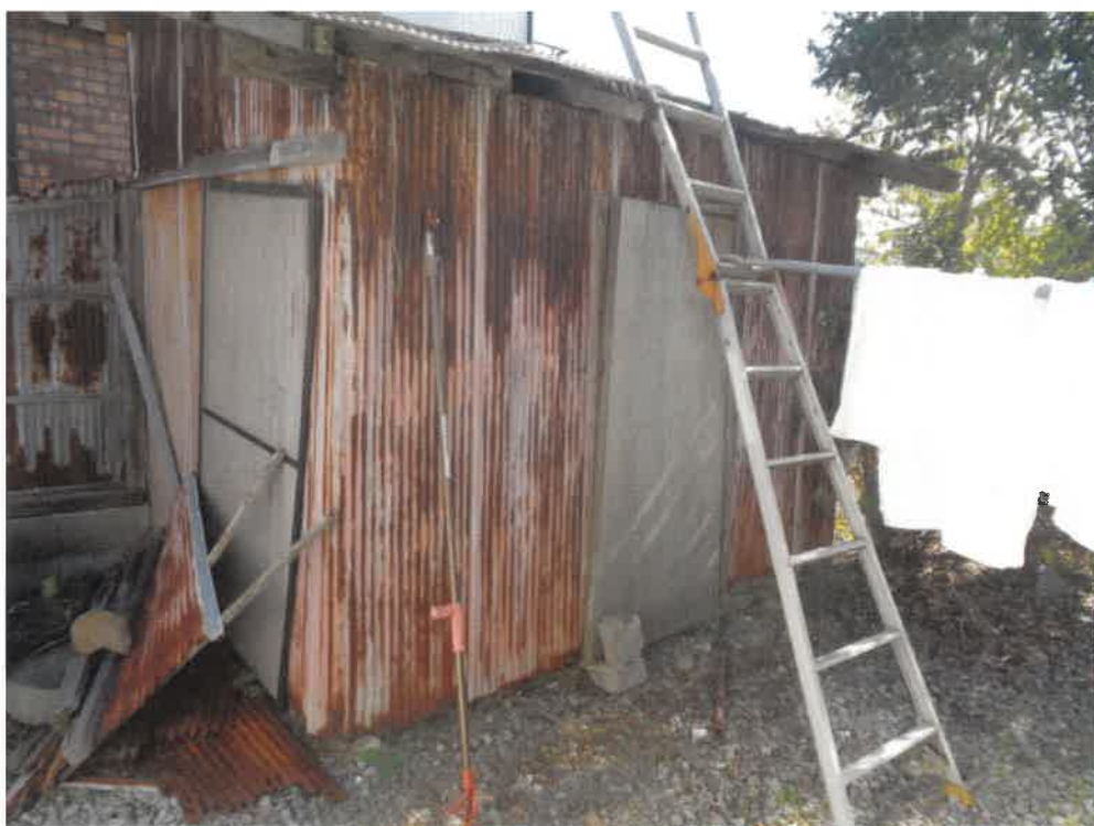
(写真2) 符号1の附属建物
