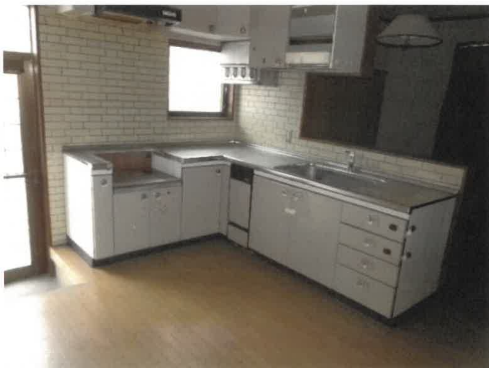
(写真 3 1) 物件 7 の建物内部 (1 階)
