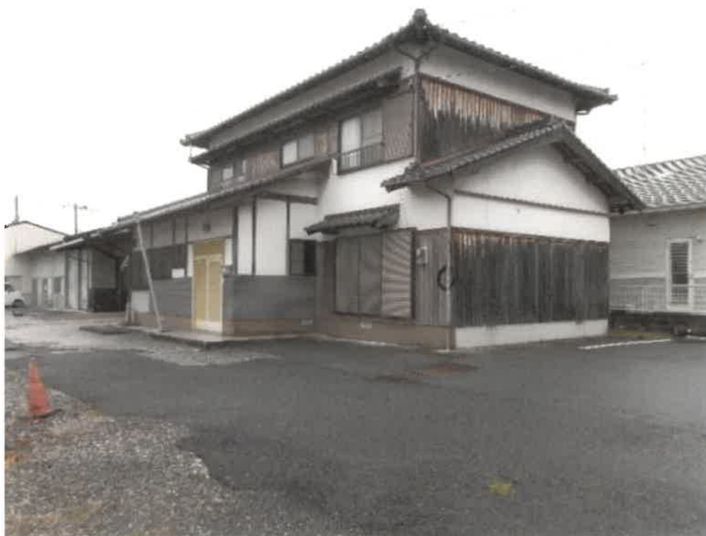
(写真8) 物件7の建物
