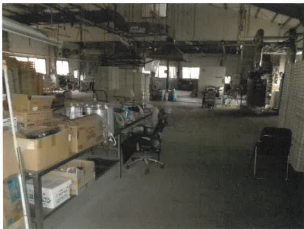
(写真 1 3) 物件 5 の建物内部 (1 階)
