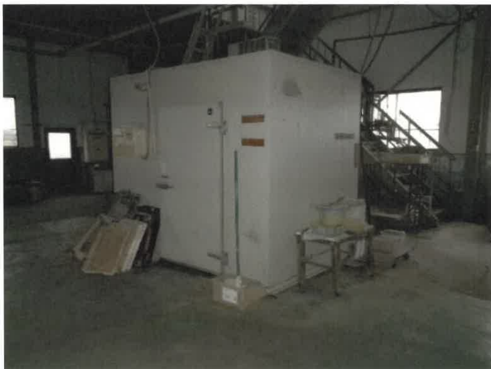
(写真 1 7) 物件 5 の建物内部のプレハブ冷蔵庫 (1 階)
