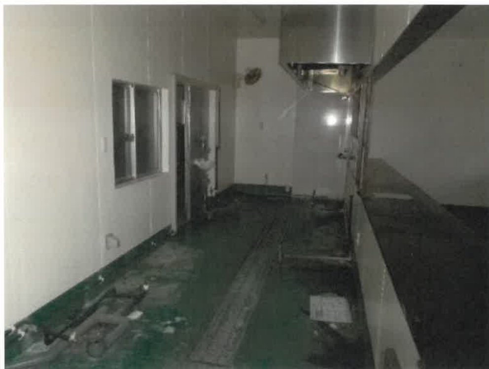
(写真 3 9) 物件 8 の建物内部
