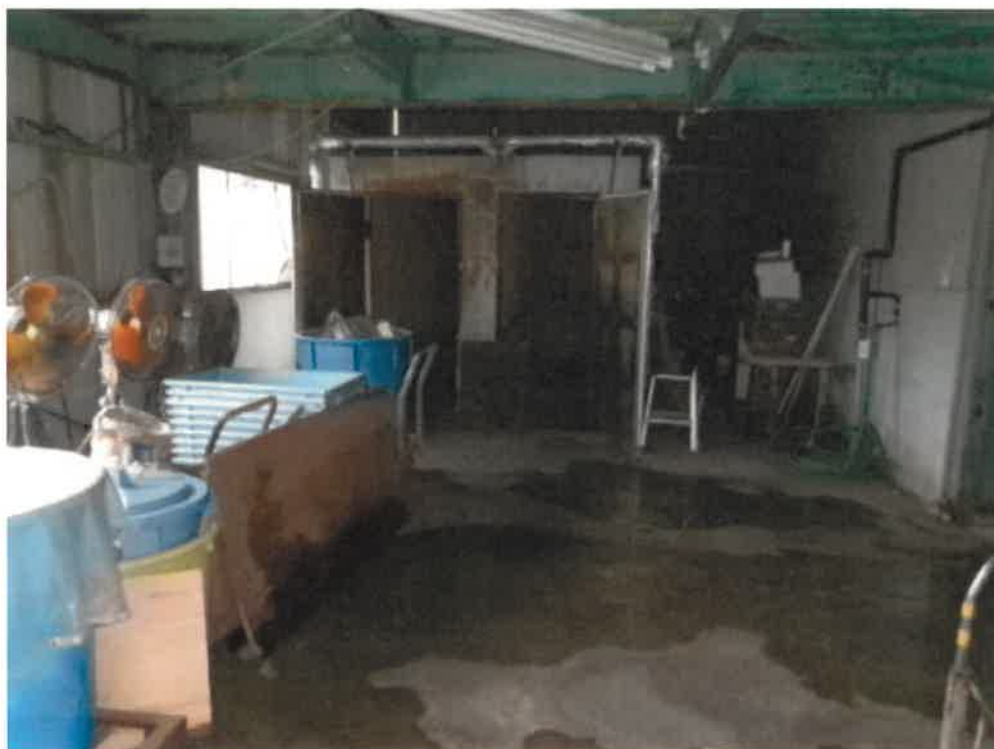
(写真 1 2) 物件 5 の建物内部 (1 階)
