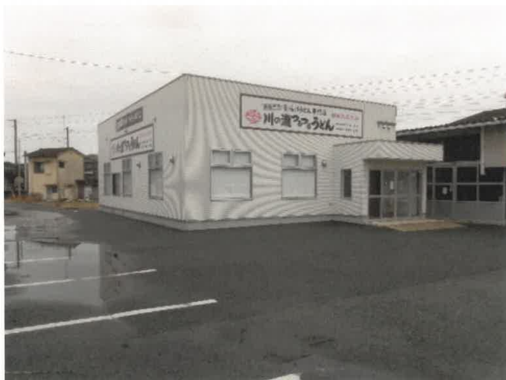
(写真9) 物件8の建物
