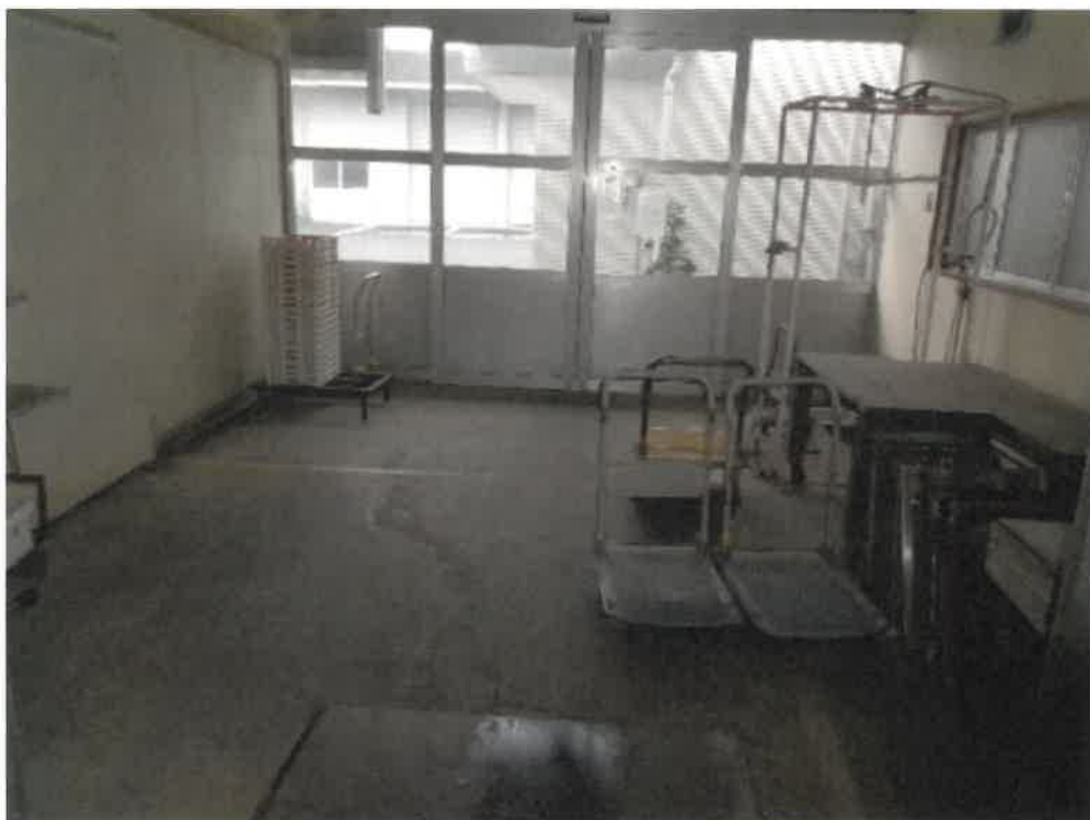
(写真 1 4) 物件 5 の建物内部 (1 階)
