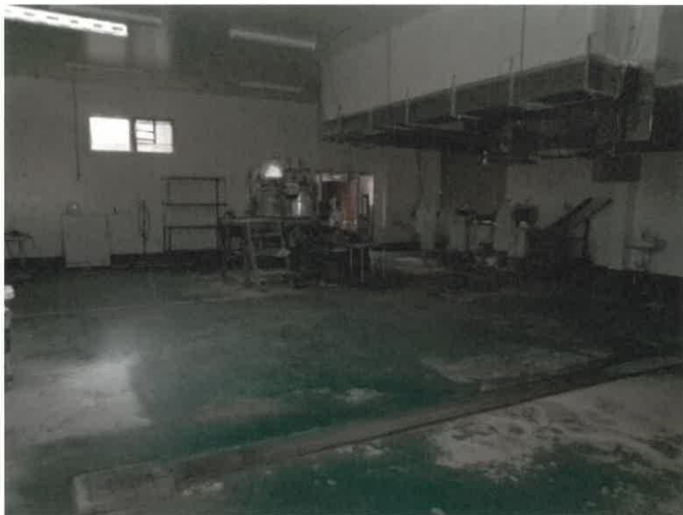
(写真 4 0) 物件 8 の建物内部
