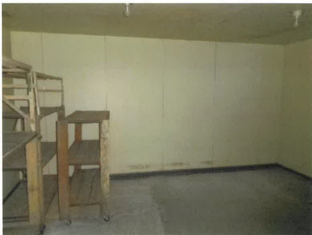
(写真 1 5) 物件 5 の建物内部 (1 階)
