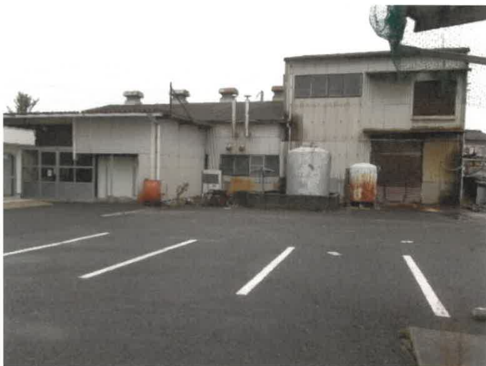
(写真1) 物件5の建物
