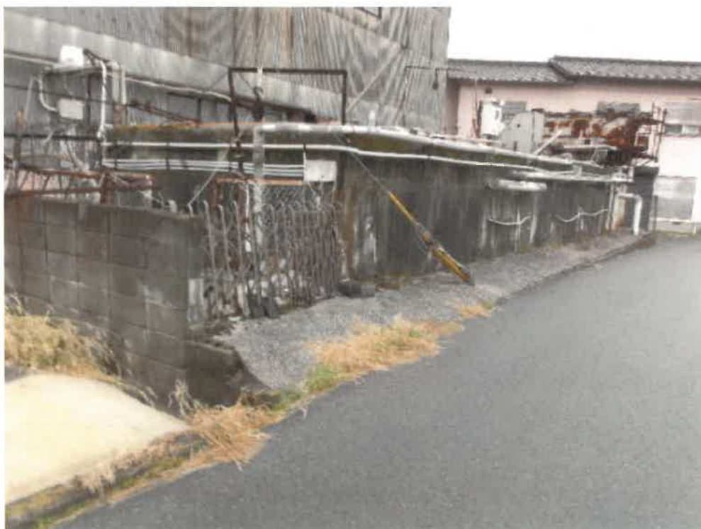
(写真 4) 売却対象物件 (物件 4 の土地の定着物) である水槽
