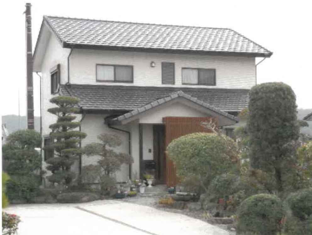
(写真5) 物件4の建物
