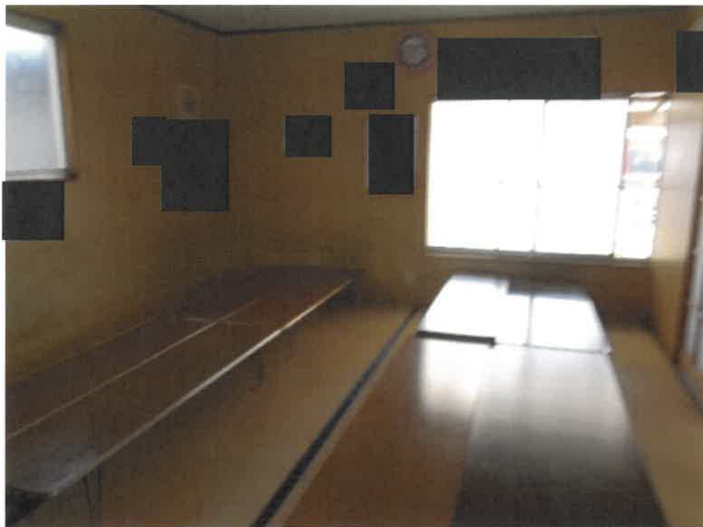
(写真 2 2) 物件 3 の未登記附属建物内部
