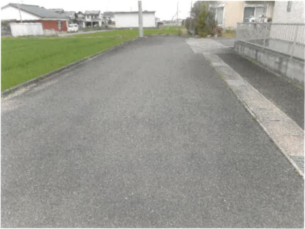
(写真3) 物件1及び2の接面道路
