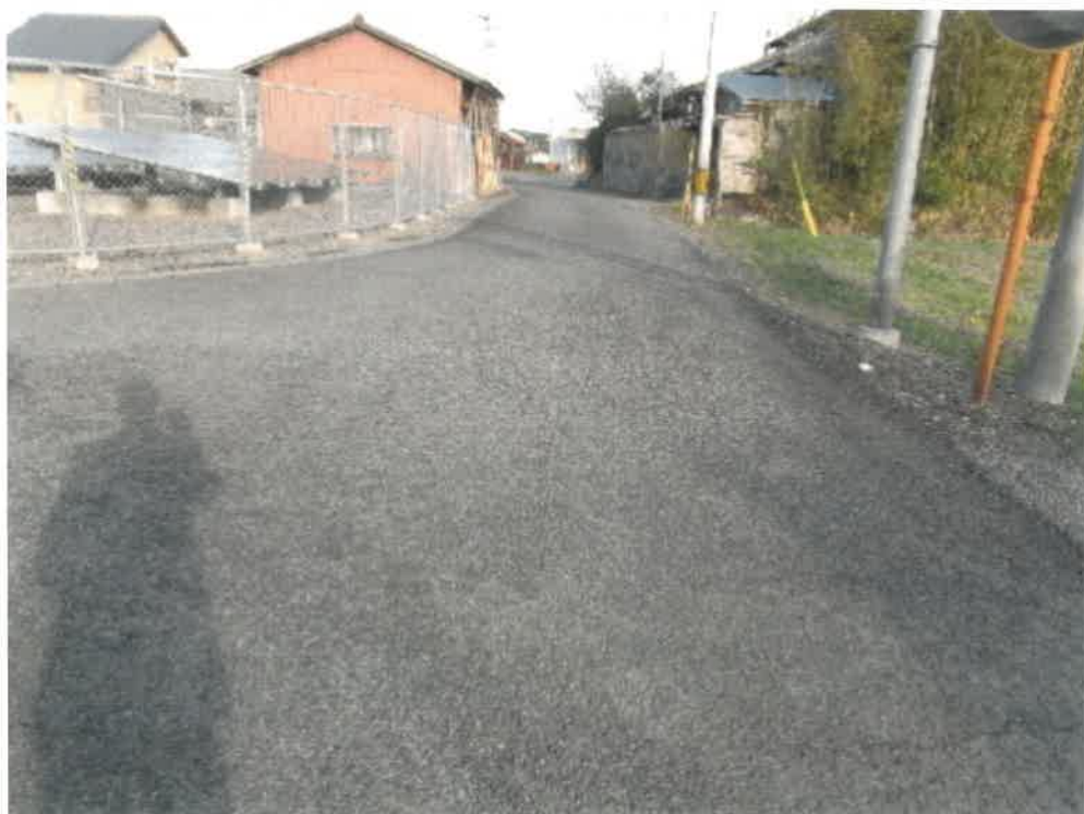
(写真5) 本件土地の接面道路
